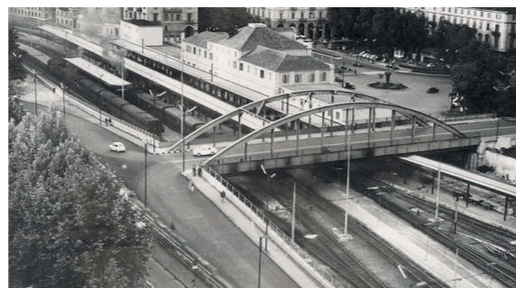
3. Inaugurazione del cavalca-ferroviario sopra Porta Susa (vista verso nordest) https://areeweb.polito.it/imgdc/schede/CE14.html (gennaio 2025)
