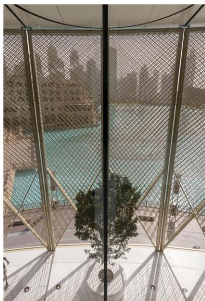
FIG. 5 APPLE STORE – SCHERMATURA IN FIBRE DI CARBONIO, CONFIGURAZIONE CHIUSA
