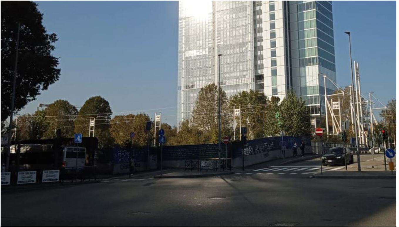
E7 Fotografia Vista lotto da C.so Bolzano
