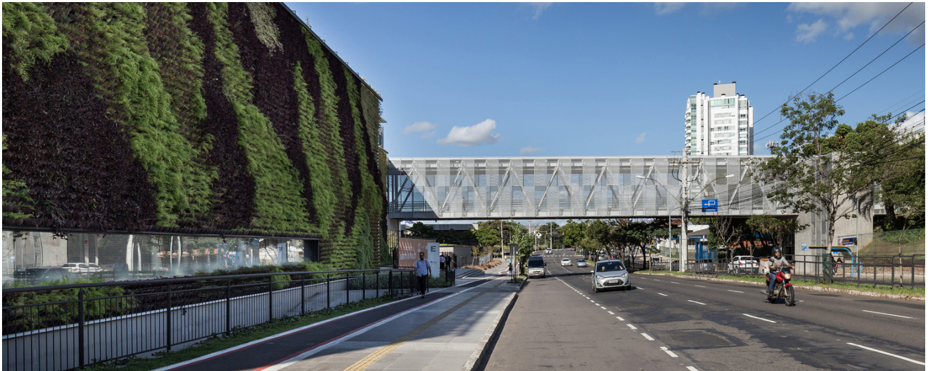
Fig. 63 AT Arquitetura, Unisinos Campus, Porto Alegre, 2017_Passerella
