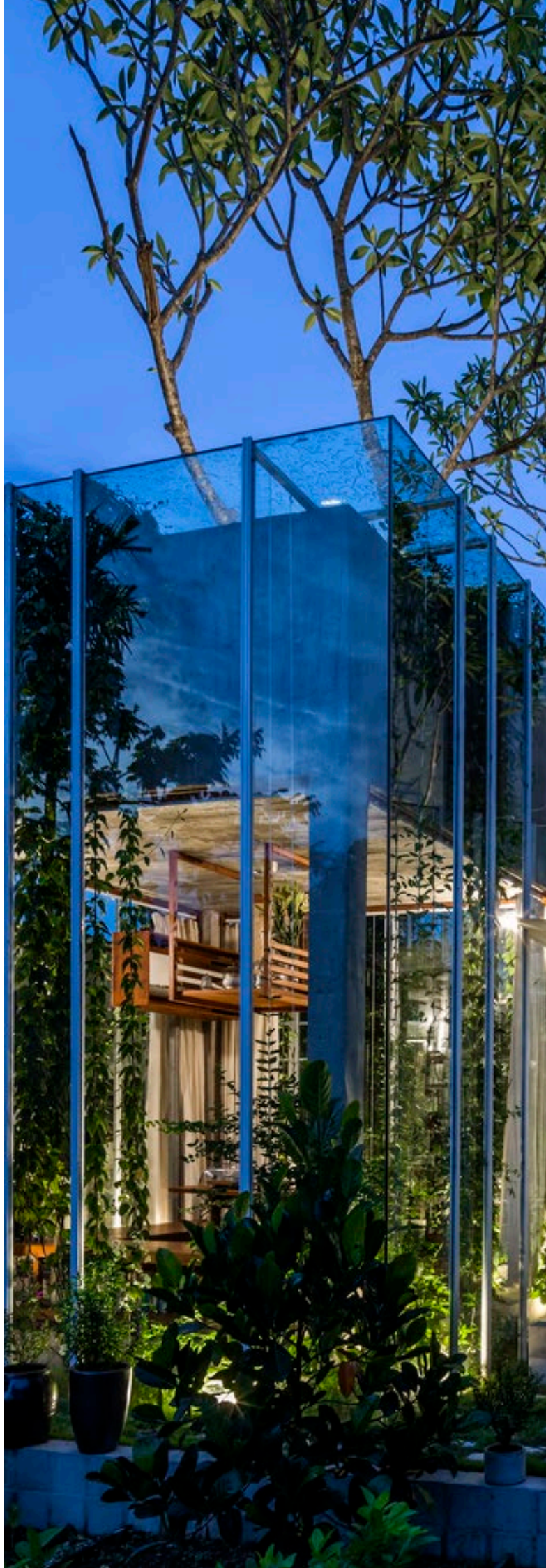
Figura 3.3.2.a Vista notturna esterna di Labri House. © Hiroyuki Oki
