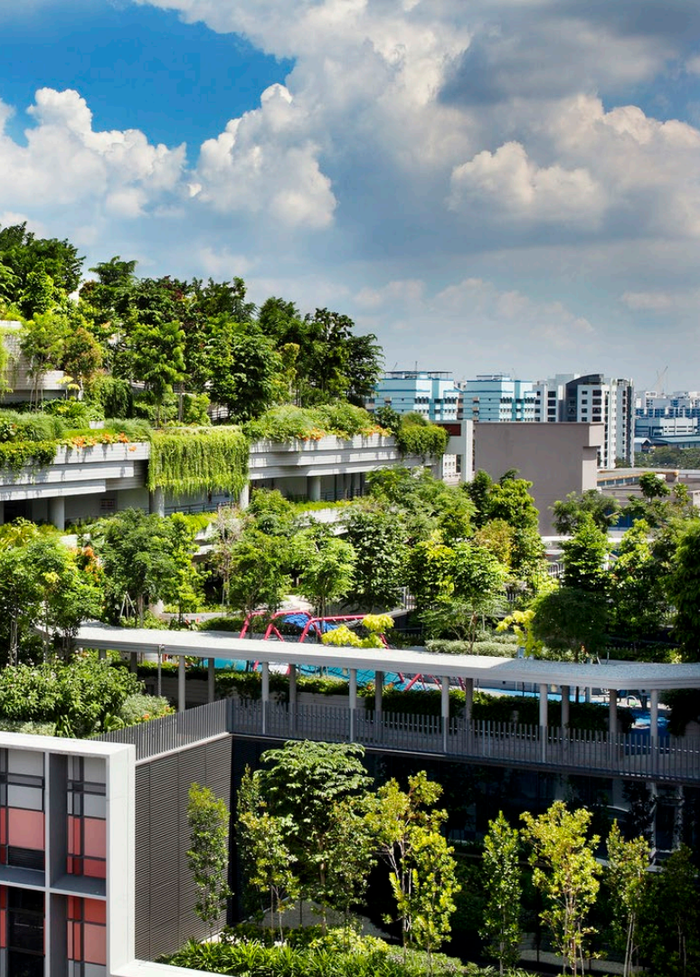
Figura 3.3.1.i Vista della vegetazione in copertura. © Patrick Bingham Hall
