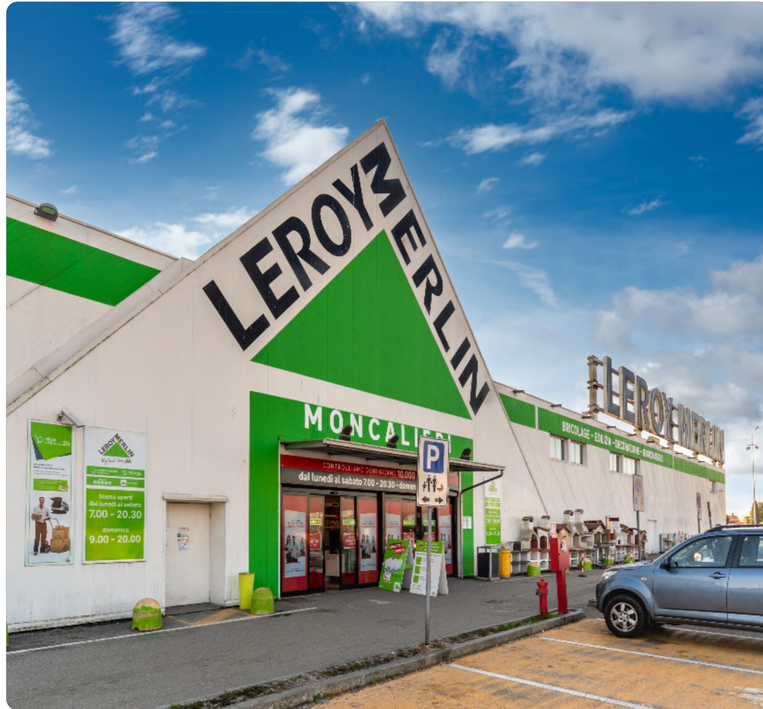
Figura 2.3 Facciata dello store Leroy Merlin di Moncalieri [20].
