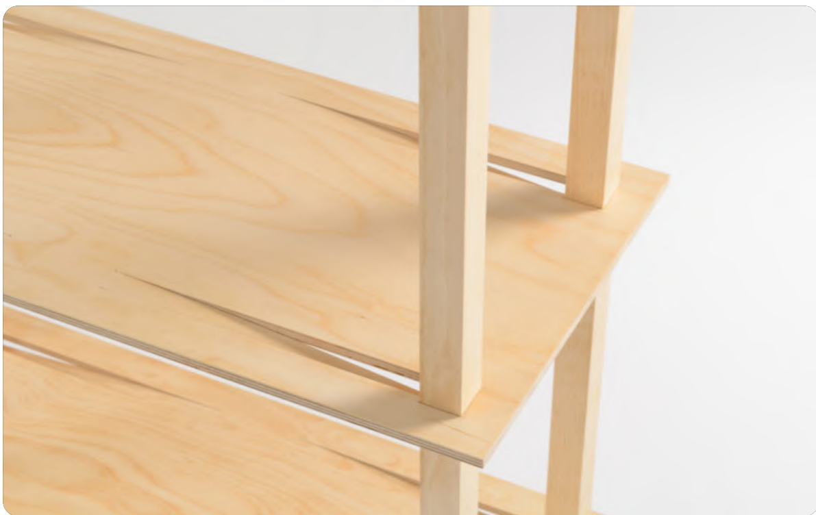
Figura 3.11 ↗ Rappresentazione grafica del funzionamento di un giunto per opposizione.
