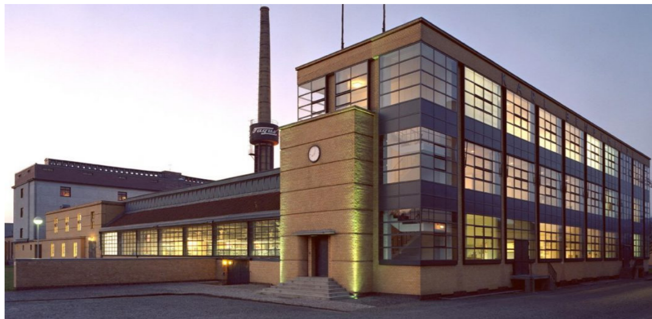
Fig. 1.7 Walter Gropius, Officine Fagus (1911-1925) vista dell'angolo con eliminazione del pilastro: la vetrata come rivestimento. https://www.teknoing.com/news/progettazione/officine-fagus-manifesto-mondiale-modernita/
