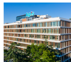
Fig. 4.1.3.21/22 Testi 280, Milano. 1980 (sinistra), 2020 (destra). L'intervento modifica il wwr, discostandosi completamente dalla preesistenza.
