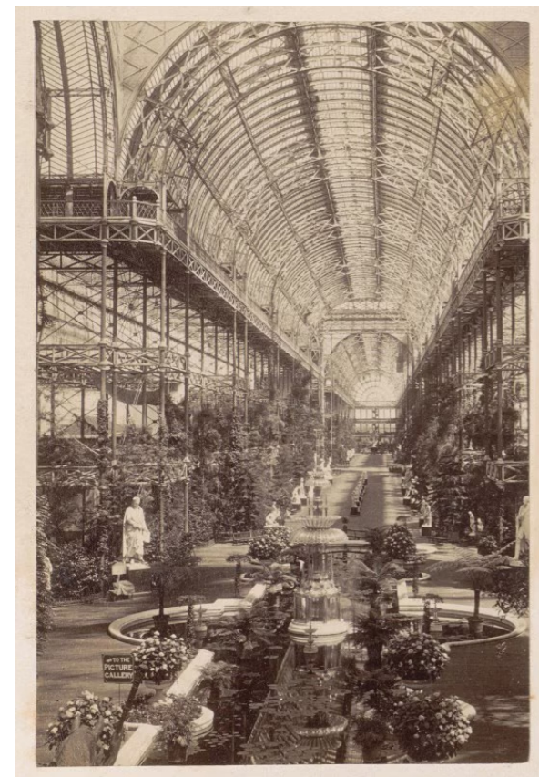
Fig. 1.3 L'interno della struttura di Paxton in una fotografia conservata al Rijksmuseum (1870-1890 ca) https://www.domusweb.it/it/edifici/crystal-palace0.html
