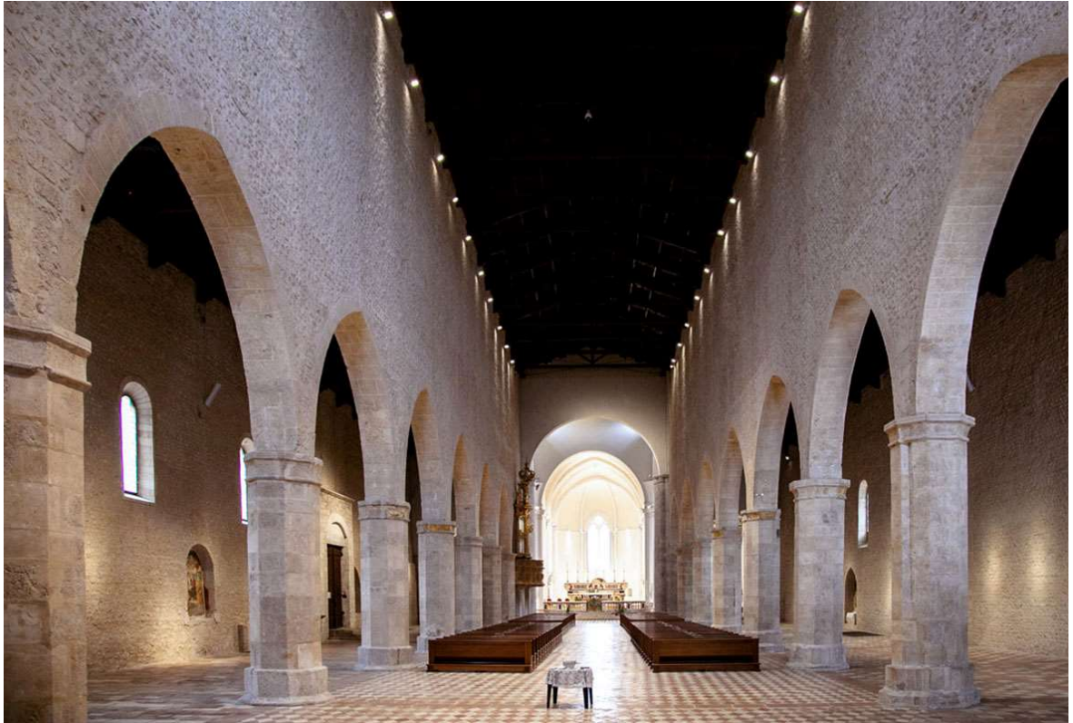
Figura 4.06. Basilica di Santa Maria di Collemaggio, L'Aquila, 2020. Immagine in seguito ai lavori di restauro, tratta dal sito del patrimonio culturale della regione Abruzzo. http://portalecultura.egov.regione.abruzzo.it/abruzzocultura/loadcard.do?id_card=7824&force=1
