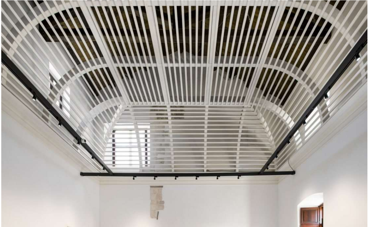
Figura 4.09. Palazzo Ardinghelli, L'Aquila, 2021. Fonte: https://maxxilaquila.art/ La riproposizione concettuale e spaziale di una volta senza ricostruirla interamente.
