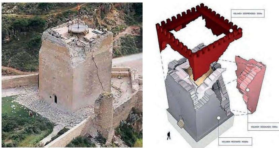
Figura 2.93. Torre del Espolon, Lorca. I danni provocati dal sisma del 2011. Fonte: Jurado, 2012.
