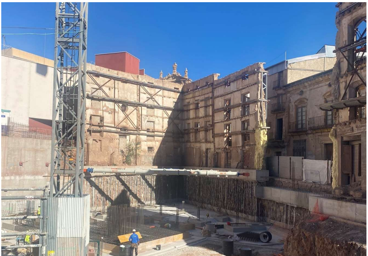
Figure 2.66 e 2.67. Lavori di ricostruzione di un edificio del centro storico.
