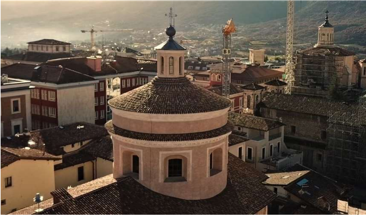
Figura 4.05. Chiesa di Santa Maria del Suffragio, L'Aquila, 2018. Vista aerea della chiesa in seguito ai lavori di restauro che mostra la ricostruzione storicistica della cupola. Fonte: https://www.santamariadelsuffragio.it/galleria/
