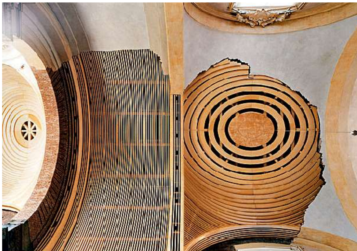
Figura 4.08. Oratorio dei Filippini, Bologna. Restauro di P.L. Cervellati. Vista della cupola dall'interno dopo l'intervento. Si noti l'eleganza della soluzione e la maestria nel gestire il punto di contatto tra materia antica e contemporanea. https://bcc.regione.emilia-romagna.it/pater/loadcard.do?id_card=151580
