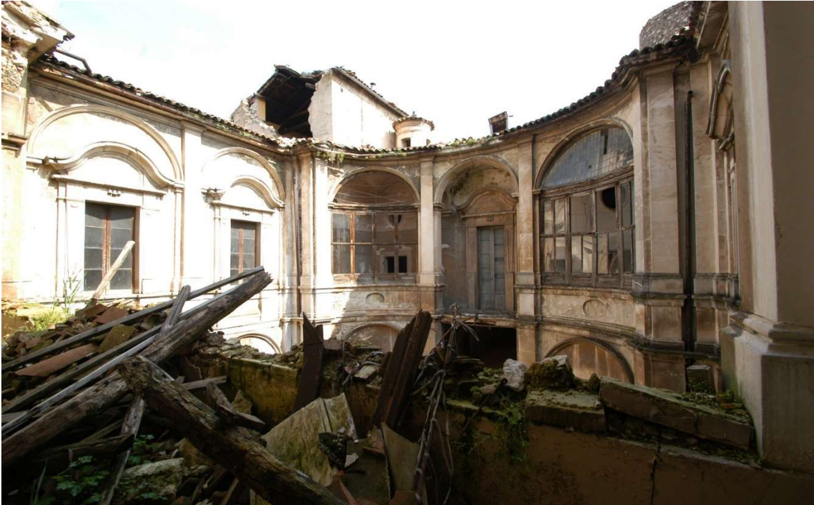
Figura 4.10. Palazzo Ardinghelli, L'Aquila, 2021. Le condizioni di degrado del patio interno distrutto in seguito al sisma del 2009.
