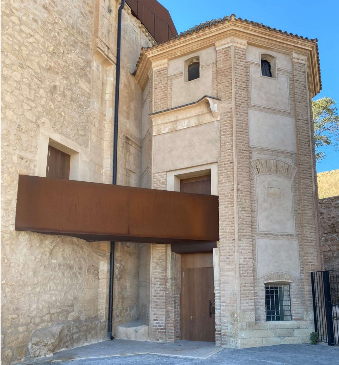
Figura 2.88. Iglesia de Santa Maria, Lorca, 2023. Vista della nuova passerella di collegamento tra la chiesa e il “camarin” esterno. Immagine dell'autore.
