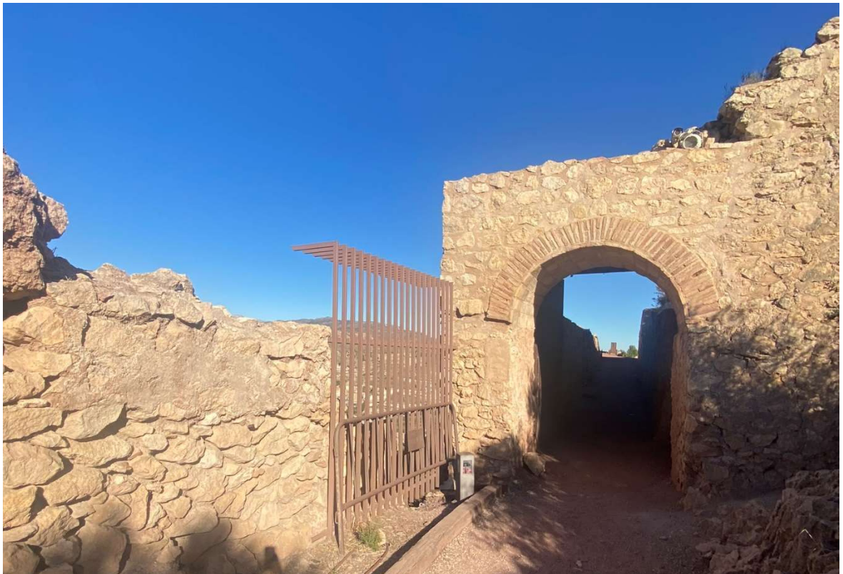
Figura 2.100. Intervento sul prospetto Nord della Muralla del Castillo de Lorca, 2023. Immagine dell'autore. Vista di una porzione della muraglia difensiva in corrispondenza della Torre del Espolon; si è deciso in questo caso di non ricostruire la muratura distrutta, ma di inserire un elemento che ne evocasse la volumetria.
