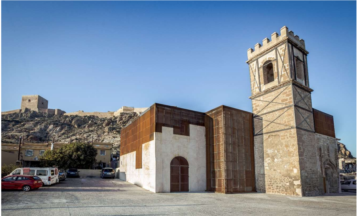
Figura 4.06. Iglesia de San Pedro, Lorca, 2019. Restauro di Chacón Bulnes Vista della chiesa in seguito ai lavori di restauro. Immagine tratta da Soleteslowfoto
