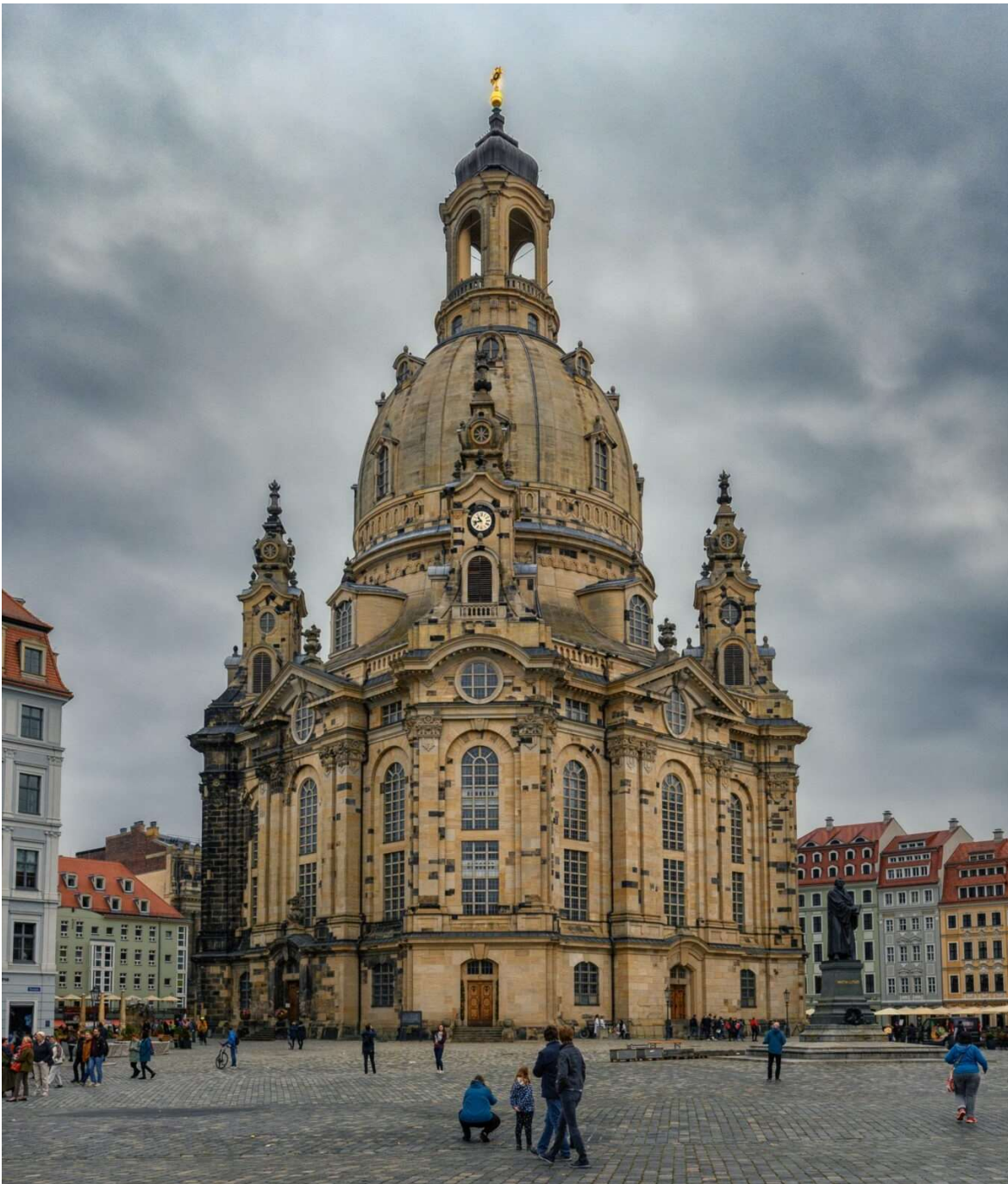
Figura 3.25. Vista della Frauenkirche, Dresda, Germania.
