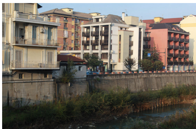
4- Argine verso area d'intervento
