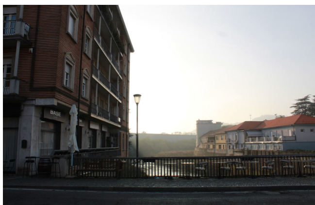
3 - Ponte sul Belbo
