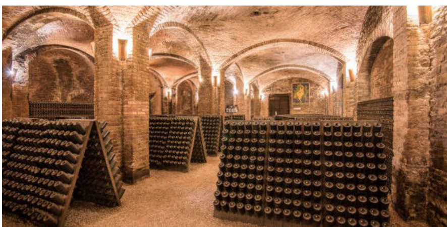
Fig.37-38_ Foto cantine sotterranee - Contratto
