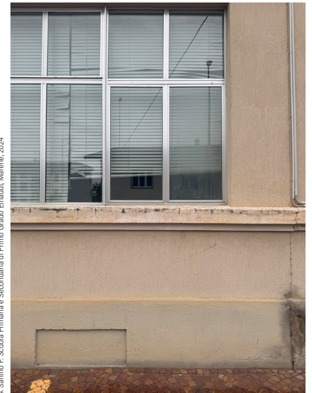
4. Sanino F. Scuola Primaria e Secondaria di Primo Grado Einaudi, Marene, 2024
