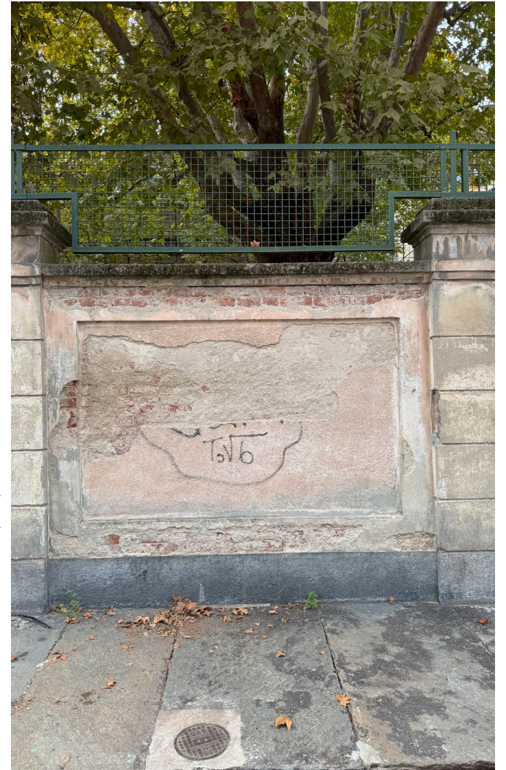
17. Sanino F. Scuola Elementare "Gian Enrico Pestalozzi", Torino, 2024
