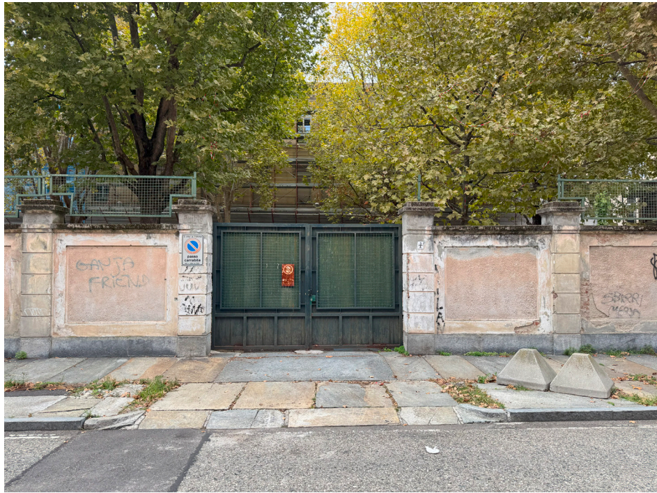
15. Sanino F. Scuola Elementare "Gian Enrico Pestalozzi", Torino, 2024
