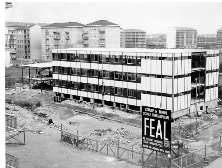
11. Il Comune di Torino fa costruire delle scuole prefabbricate, Torino, 1962.
