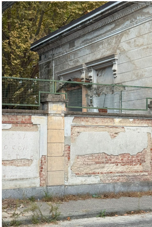
16. Sanino F. Scuola Elementare "Gian Enrico Pestalozzi", Torino, 2024
