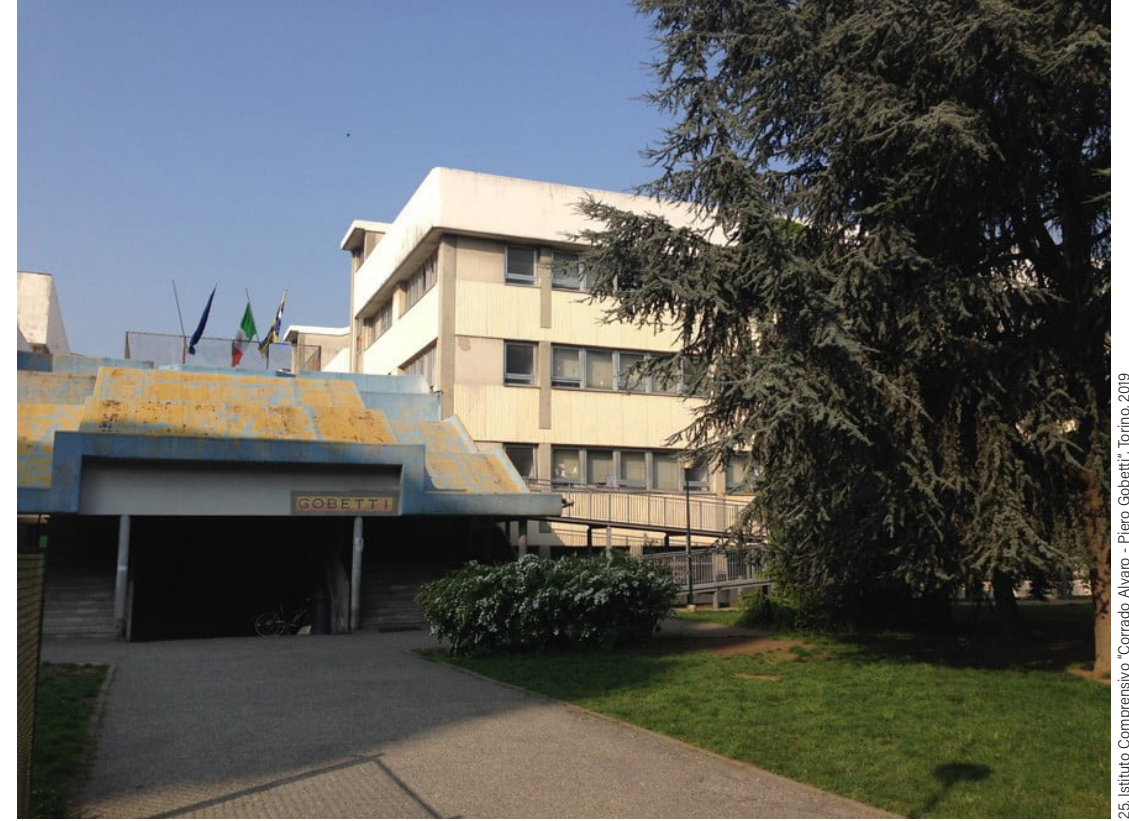
25. Istituto Comprensivo "Corrado Alvaro - Piero Gobetti", Torino, 2019
