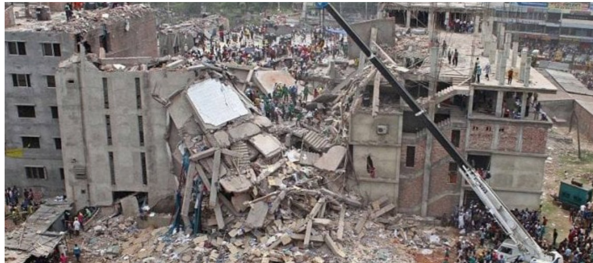
Quel che restava del Rana Plaza a poche ore dal crollo
