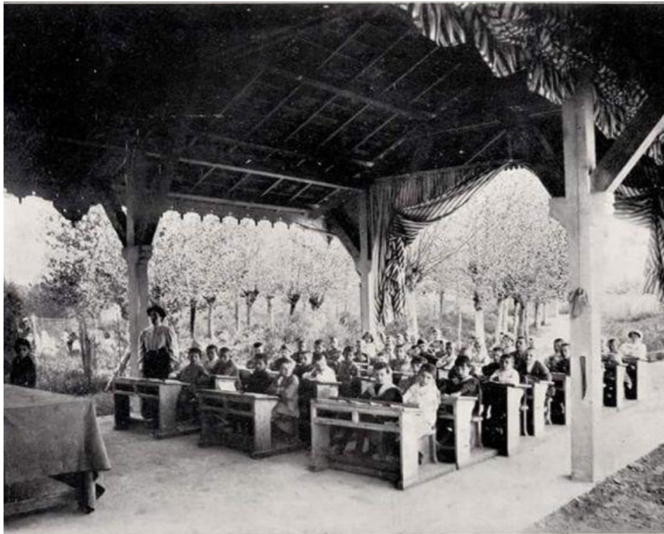
Fig.12_ Interno tettoia scuola all'aperto "C.Aita", Padova.
