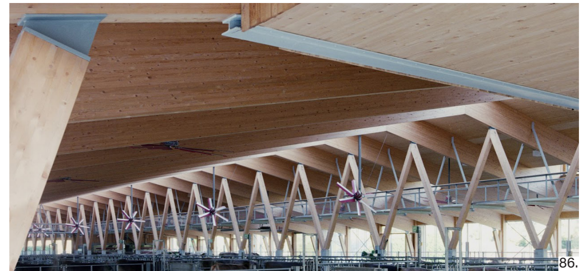
Fig.86 Orditura di pilastri a V che sorreggono la copertura e supportano la passerella
