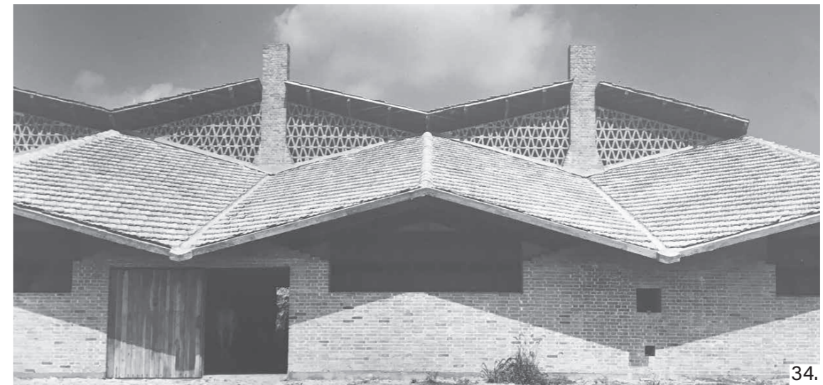
Fig.34 Vista parziale del prospetto della stalla n. 1
