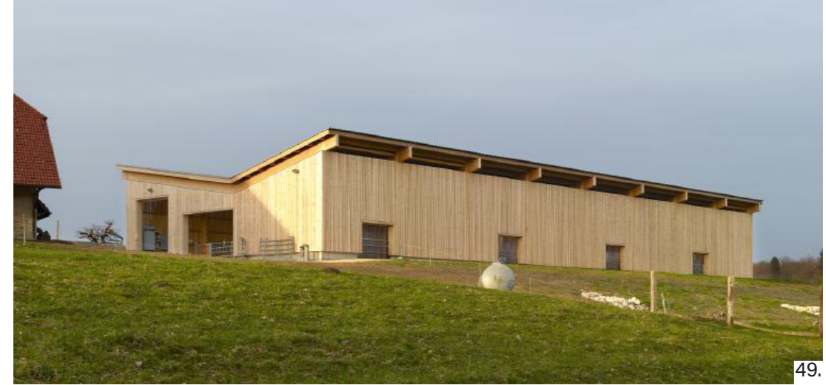
Fig.49 Vista dell'edificio nel suo contesto
