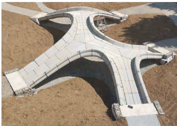
(69) Il ponte Phoenix appena terminato (Fonte: Fabricate 2024 pp. 96)
