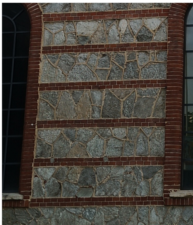
(188) Muro di facciata OGR, com'è possibile notare le pietre ricordano il pattern Voronoy
