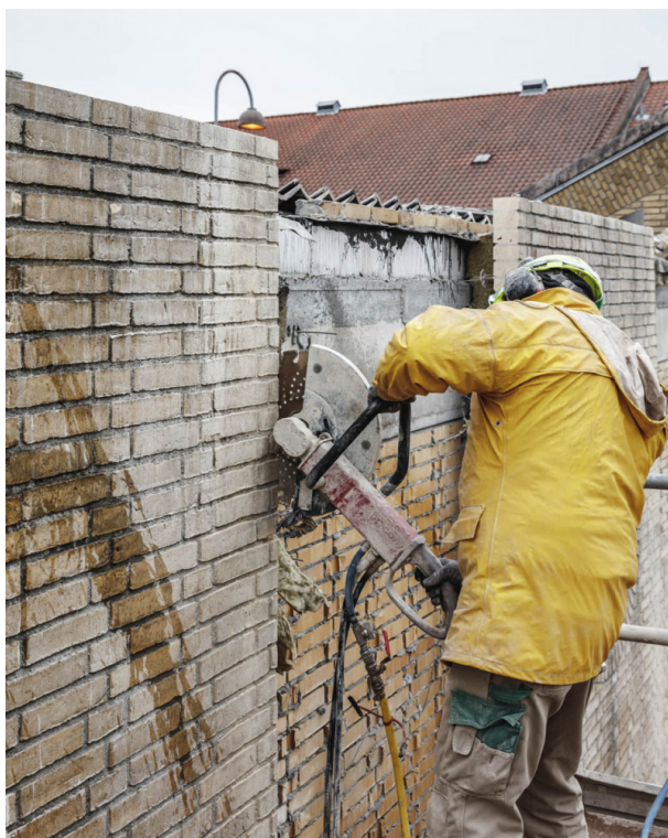
(172) Taglio delle murature in mattoni (fonte: Lendager.com)
