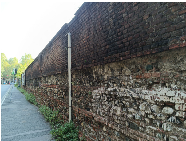
(174) 1 - Muro di cinta cantiere a lato stazione porta Susa (Foto realizzata durante sopralluogo)
