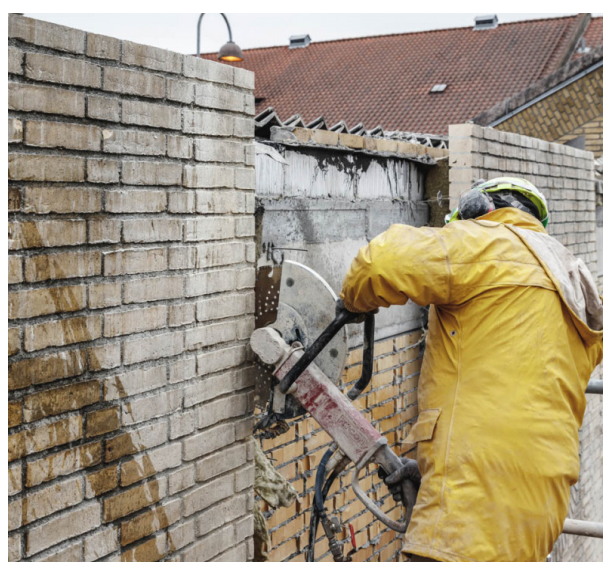
(106) Taglio di un segmento di muro da 1 m 2 (Fonte: lendager.com).
