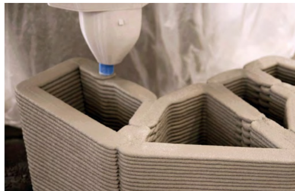
(67) Percorso di stampa del ponte Phoenix (Fonte: Fabricate 2024 pp. 95)
