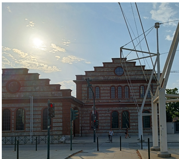
(169) Facciata OGR (foto realizzata durante sopralluogo)
