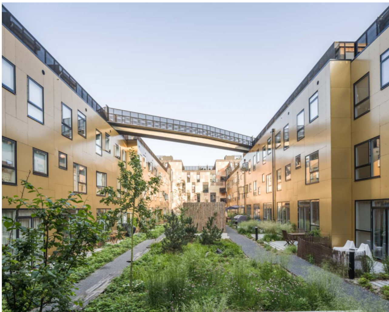
(105) Corte interna con giardini e piccoli edifici in legno recuperato, in alto la passerella realizzata con una trave in cemento armato di recupero. (Fonte: lendager.com).
