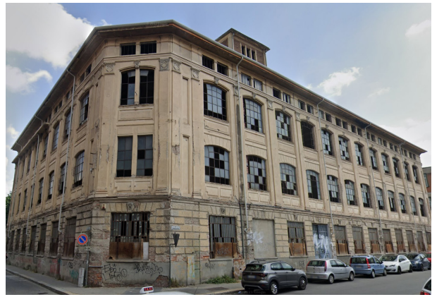
(177) 4 - Fabbrica abbandonata, corso Mortara (Fonte: Google maps)
