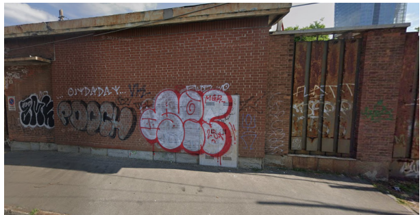
(178) 5 - Muro di recinzione cantiere via Passo Buole (Fonte: Google maps)
