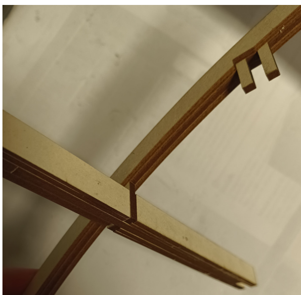
(489) Assemblaggio travi principali con secondarie
