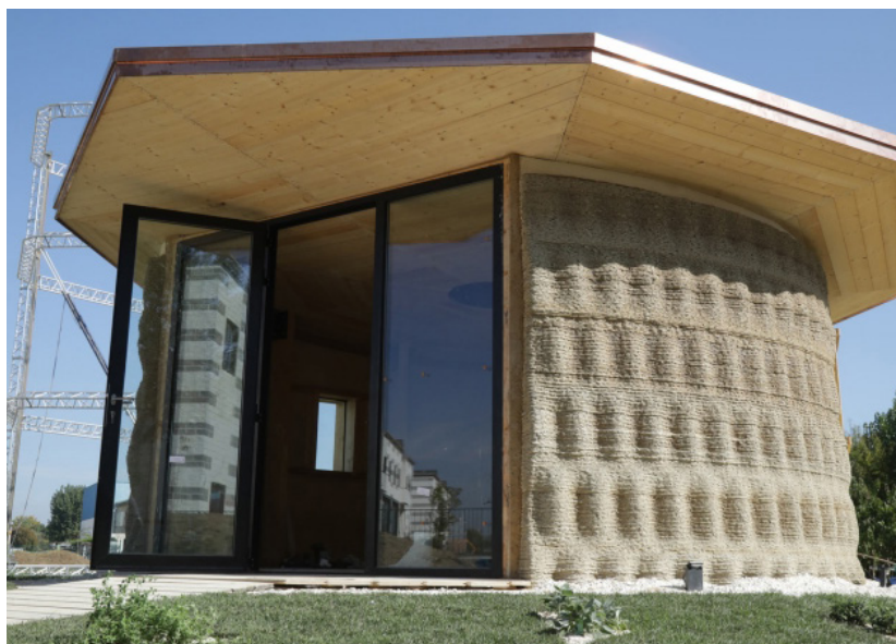
[42] Casa stampata in argilla dall'azienda WASP (Fonte: Replicatore.it)
