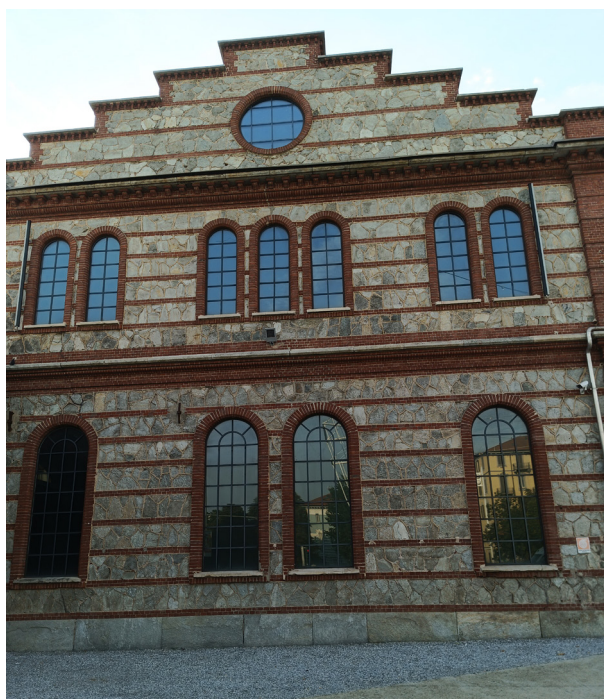
(170) Dettaglio facciata OGR (foto realizzata durante sopralluogo)
