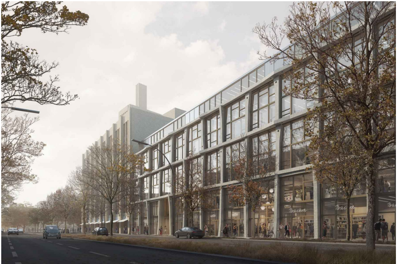
(107) Prospetto esterno con struttura realizzata dalle vecchie travi in cls. (Fonte: lendager.com).
