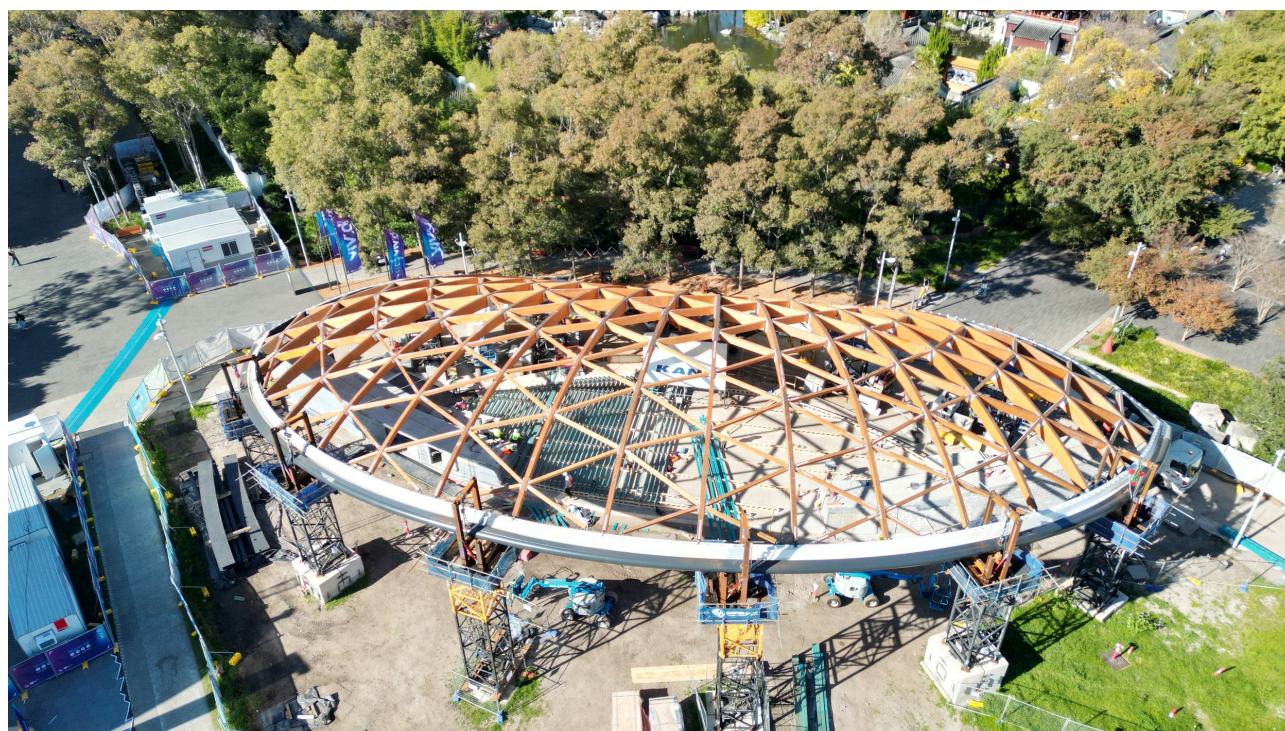
(I2)Progetto Tumbalong Green durante la fase di cantiere. (Fonte: En-code.io).
