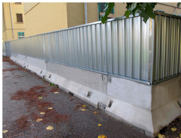
(380) Esempio barriera in lamiera grecata (Fonte: Cementisolai.it)
