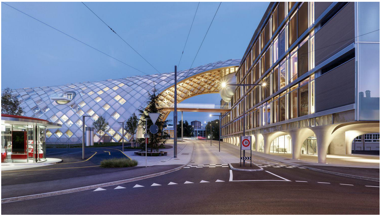
(56) Vista esterna Swatch headquarter (Fonte: geniuslociarchitettura.it )
