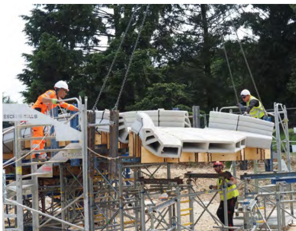
(68) Fase di assemblaggio del ponte Phoenix (Fonte: Fabricate 2024 pp. 95)
