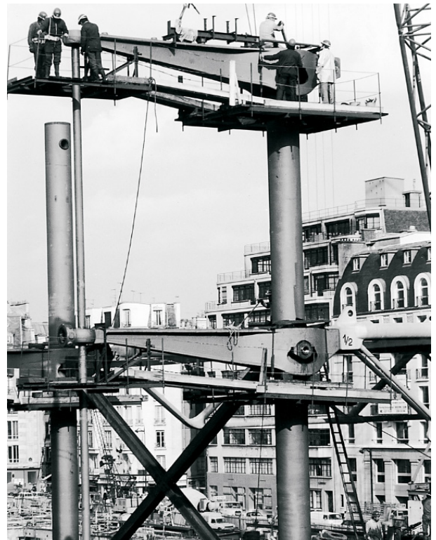
(12) Trave Gerber del prospetto principale del centro (Fonte: Corriere della sera - Living)
