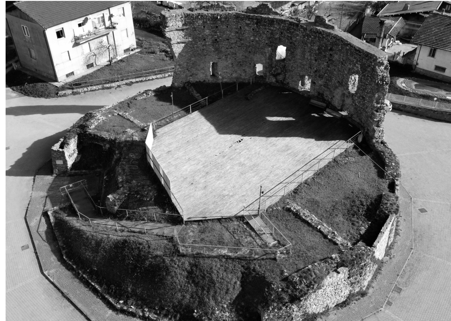
(79) Immagine dello stato attuale del castello abbandonato ( Sopralluogo Novembre 2024 )
