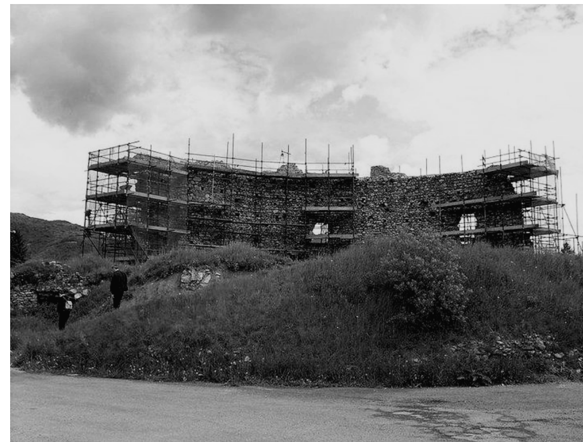
(72) Fotografia del castello durante il primo restauro, 2007 (fonte: https://it.wikipedia.org/wiki/File:Bardineto-IMG_0415.JPG )
