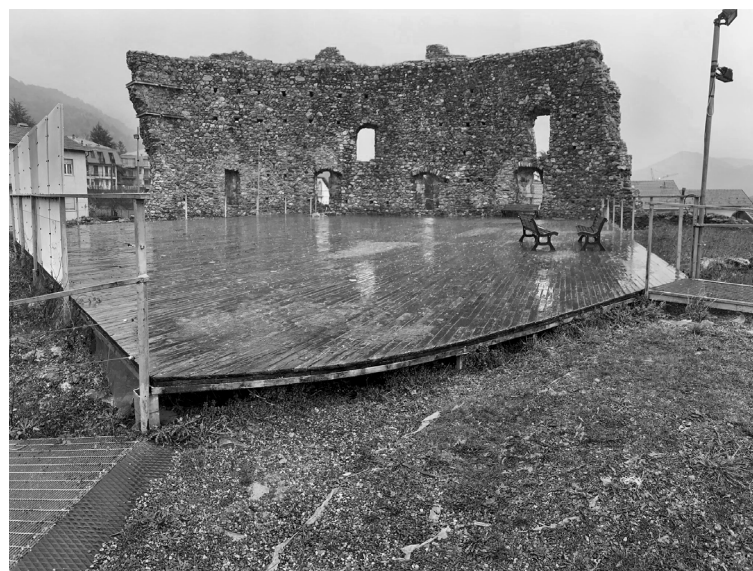
(20) Stato di abbandono del castello di Bardineto ( Sopralluogo Ottobre 2021 )
