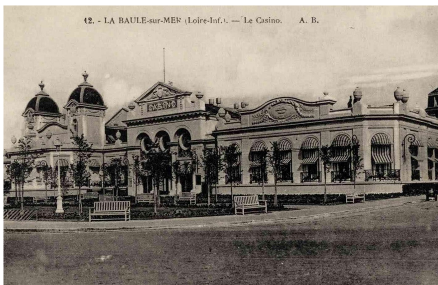
La Baule, il casinò. Facciata completa del casinò fronte mare. Cartolina. s.d. Archivio dipartimentale della Loira Atlantica
