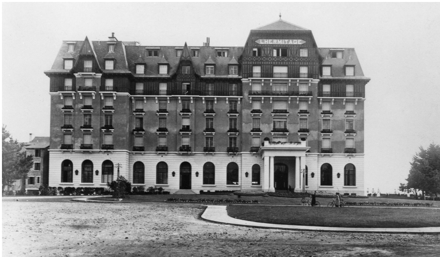
Hôtel Hermitage, facciata Nord. Cartolina. 1926. Inventario du Patrimoine des Pays de la Loire
