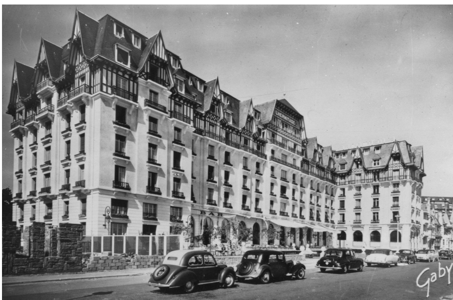
Hôtel Hermitage, facciata Sud. Cartolina. ca. 1930. Inventario du Patrimoine des Pays de la Loire
