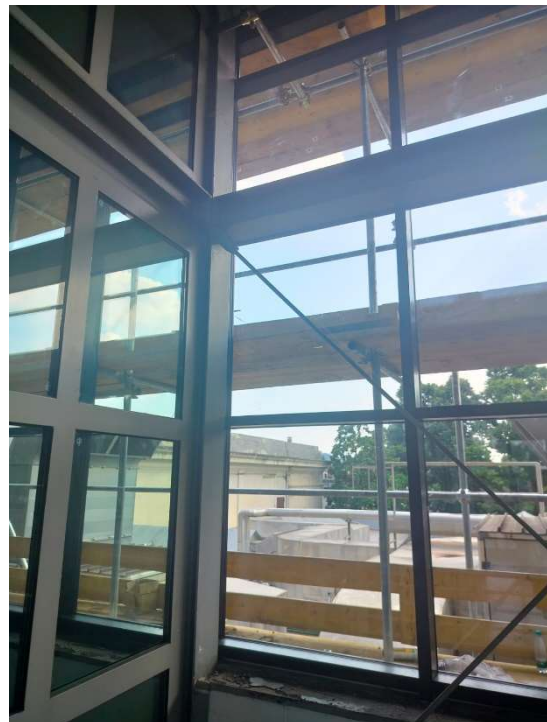
Figura 48 a) Intervento sui serramenti, rimozione delle finestre ed installazione di un telo nero. b) installazione di montanti sulla facciata sud/est dell'edificio. fonte: elaborazione propria, 18-07-2024
