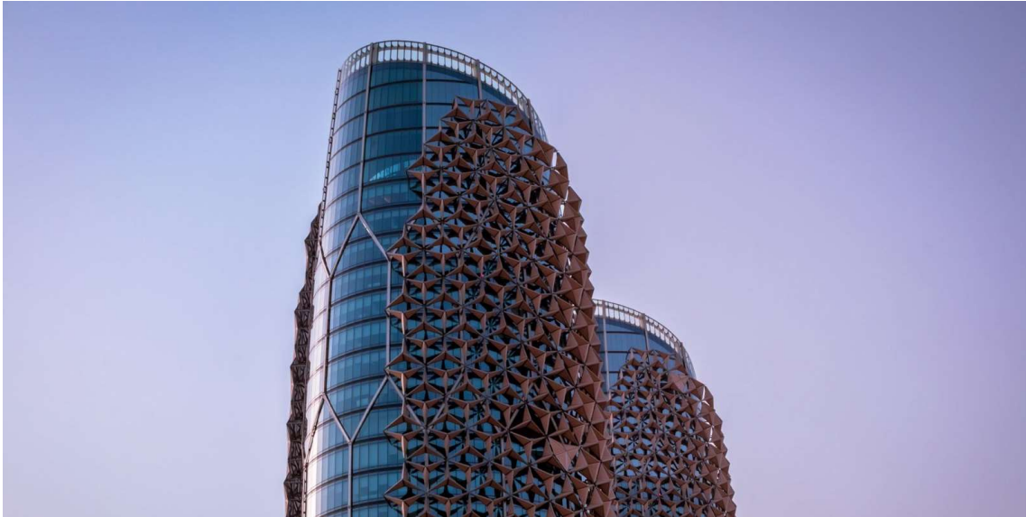
Figura 36 Vista del sistema di facciata adattiva delle Al Bahar Towers, 2012. Fonte: Fabiana Valentini, "Al Bahar Towers, le torri di Abu Dhabi con facciata solare intelligente" (2024)
