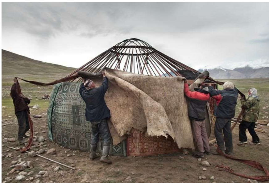
Figura 8 Sinistra: Costruzione dell'Iurta Mongola. Primi stili di rifugio nomade in Asia centrale. Fonte: "Encyclopedic entry. Yurt", National Geographic (Paley, 2024).
