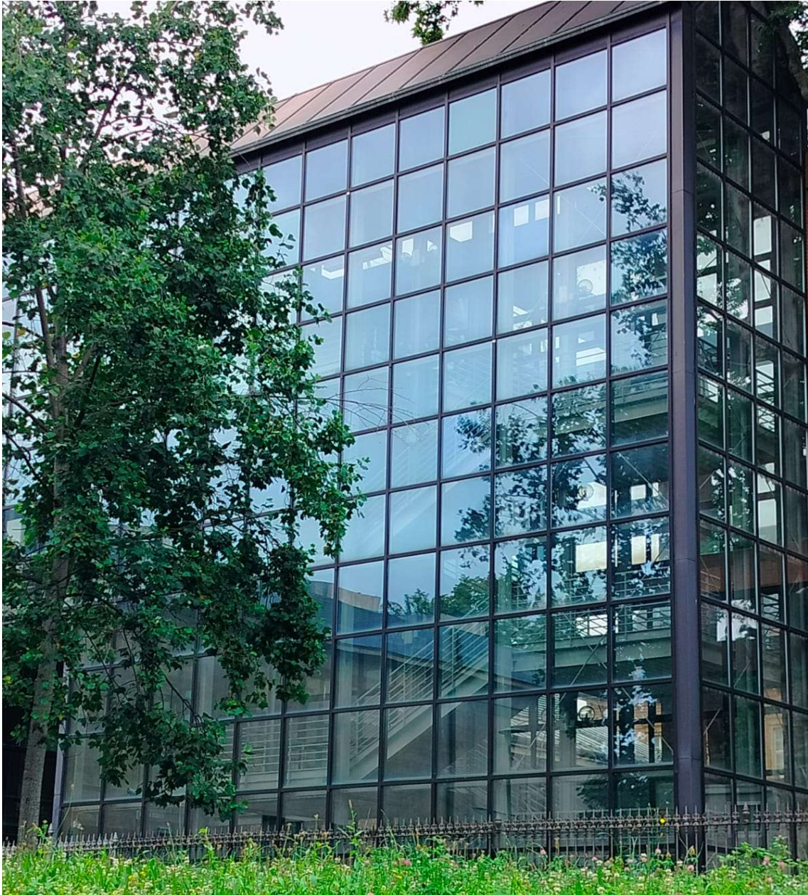
Figura 42 Vista sud-est della “Manica Nuova” presso la sede “Castello del Valentino” del Politecnico di Torino. Involucro verticale completamente trasparente. Fonte: elaborazione propria, 23-05-2024
