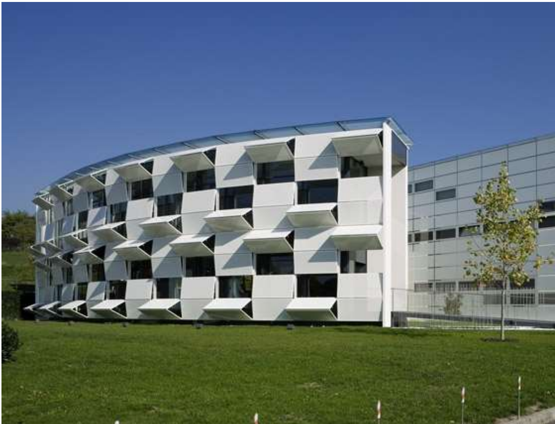
Figura 40 Vista esterna dell'edificio con i moduli attivati in alternanza. Fonte: "Dynamic Façade (Kiefer Technic showroom)" (Ott, 2024)
