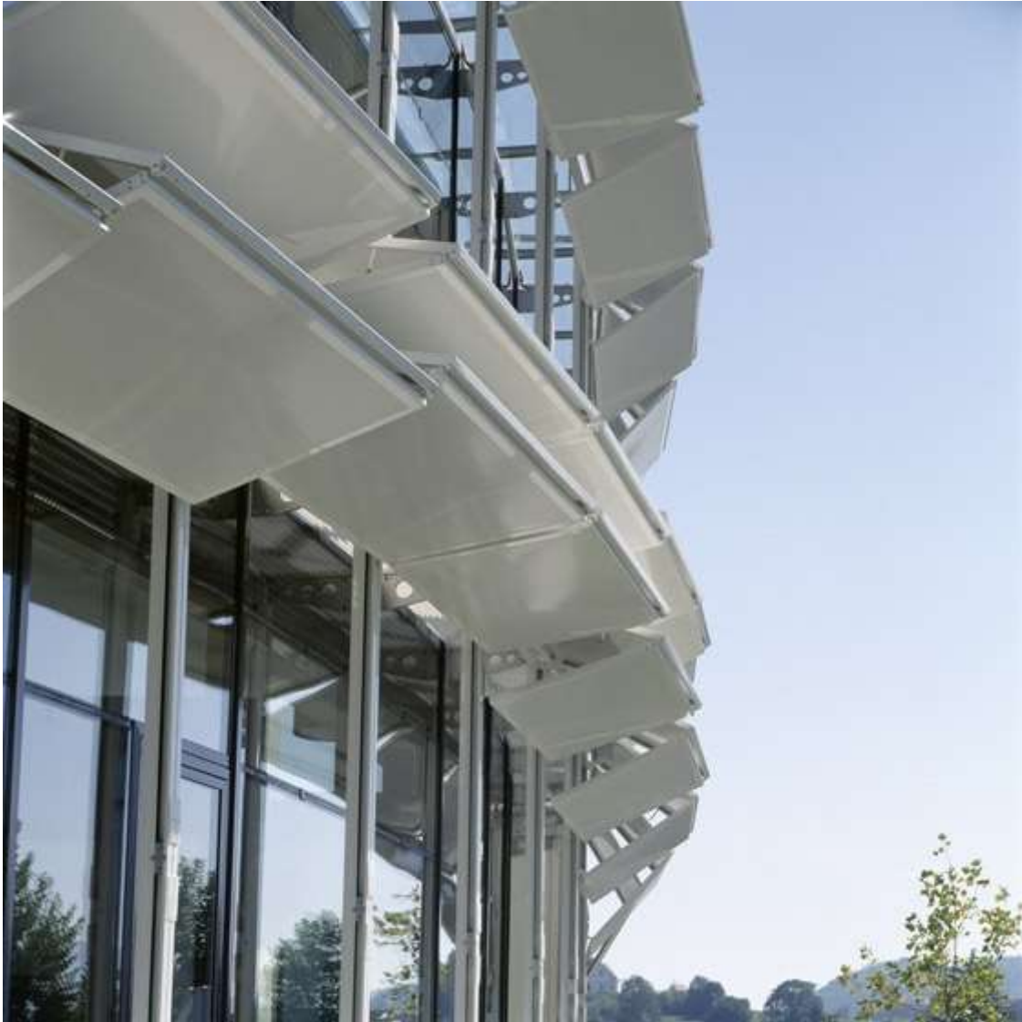
Figura 41 Vista particolare di ogni modulo aperto. Fonte: "Dynamic Façade (Kiefer Technic showroom)" (Ott, 2024)
