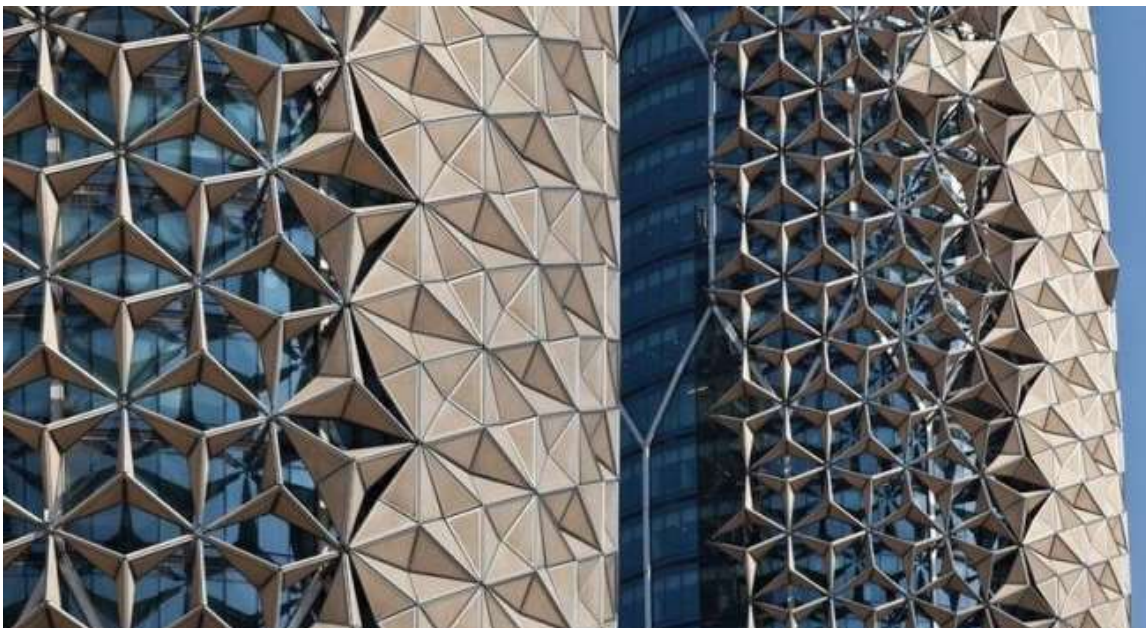
Figura 14 Al Bahar Towers dello studio Aeda, Abu Dhabi, 2012. Fonte: Fabiana Valentini, "Al Bahar Towers, le torri di Abu Dhabi con facciata solare intelligente" (2024)
