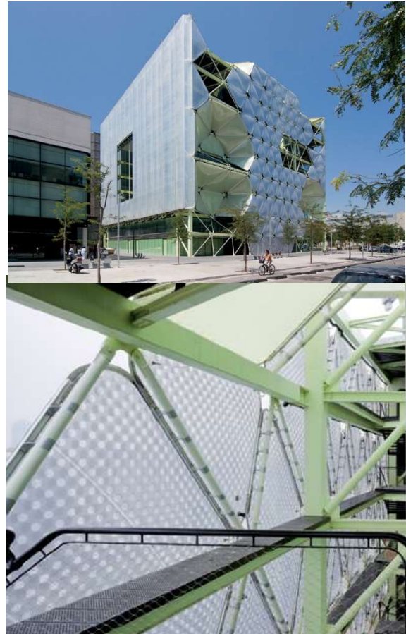
Figura 34(Superiore) Vista delle facciate CAC e Sancho D'Ávila. (Inferiore) Vista dell'involucro adattivo dall'interno. Fonte: "Media-TIC Building" (J.M. Hernandez e I. Baan, 2024)
