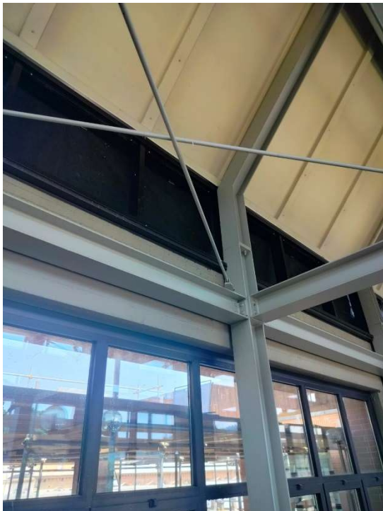
Figura 48 a) Intervento sui serramenti, rimozione delle finestre ed installazione di un telo nero. b) installazione di montanti sulla facciata sud/est dell'edificio. fonte: elaborazione propria, 18-07-2024
