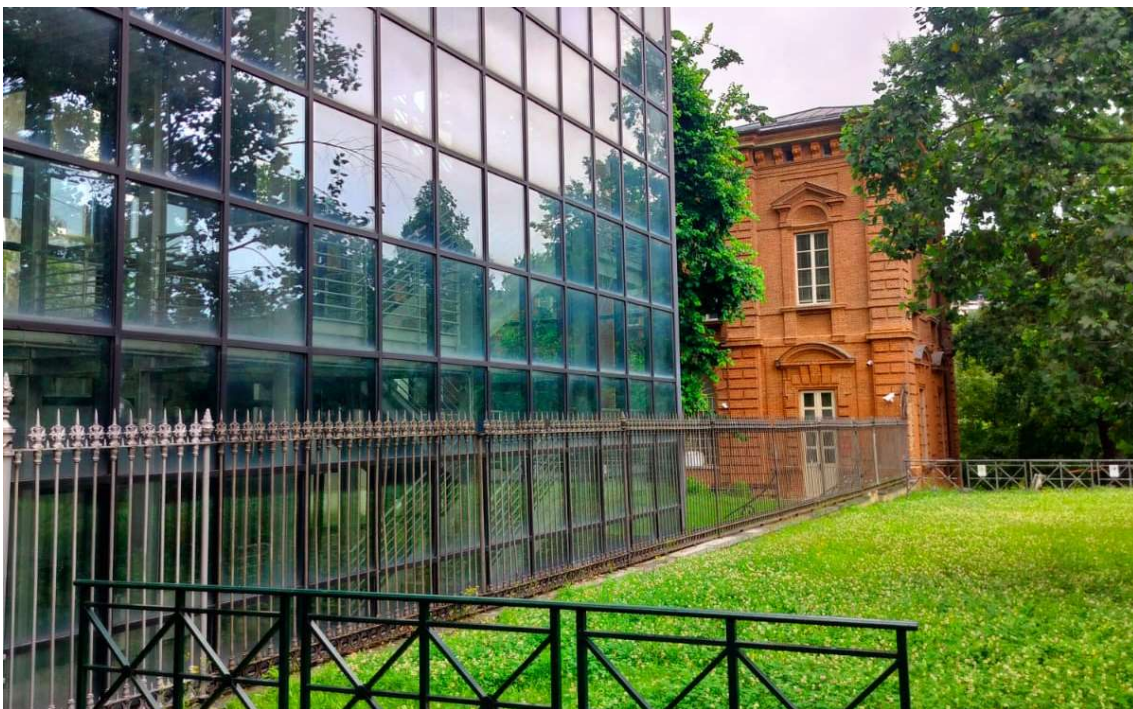
Figura 66 Facciata "Ala Nuova" in confronto all' edificio adiacente, la ringhiera delimita il confine edificabile e la griglia di progetto 100x100cm definita dai telai delle finestre. Fonte: elaborazione propria, 23-05-2024
