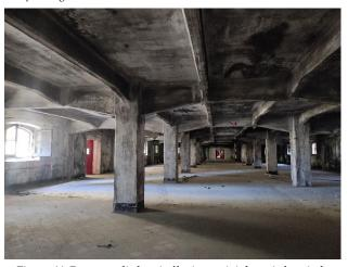
Figura 44: Presenza di alcuni effetti negativi dovuti al periodo di abbandono (fenomeno dell'umidità). Fonte: *riproduzione* personale mediante sopralluogo (settembre 2022)
