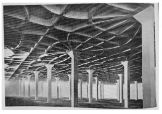
Figura 7: I solai "a nervature isostatiche" del Lanificio Gatti di Roma (Tavola XLV in P.L Nervi, Costruire Correttamente). La Manifattura Tabacchi a Bologna. Ricerche sull'architettura industriale contemporanea tra storia, tecnica e riuso, Bononia University Press, 2019
