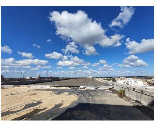
Figura 52: Guaina bituminosa impermeabilizzante usurata, disgiunta e mancante (vista dal tetto). Fonte: *riproduzione* personale mediante sopralluogo (settembre 2022)
