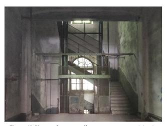
Figura 45: Vano scala con castelletto ascensore arrugginito, in stato pericolante e privo di porta di protezione. Fonte: riproduzione personale mediante sopralluogo (settembre 2022)
