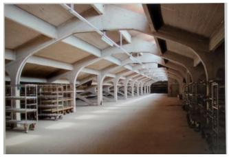
Figura 11: Manifattura Tabacchi di Firenze, copertura in cemento armato, ingg. Nervi & Nebbiosi. Foto Massimo Preite, 2010. *Le fabbriche del tabacco in Italia. Dalle manifatture al patrimonio*, Celid, Torino, 2012.
