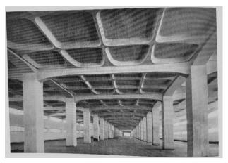
Figura 8: I solai del Magazzino "Ballette" della Manifattura Tabacchi di Bologna (Tavola XLII in P.L. Nervi, Costruire Correttamente) del Lanificio Gatti di Roma (Tavola XLV in P.L Nervi, Costruire Correttamente). La Manifattura Tabacchi a Bologna. Ricerche sull'architettura industriale contemporanea tra storia, tecnica e riuso. Bononia University Press, 2019.
