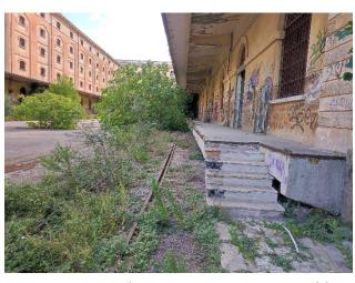
Figura 48: Presenza di vegetazione spontanea e atti vandalici sulla facciata della corte interna. Fonte: *riproduzione personale mediante sopralluogo (settembre 2022)*
