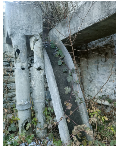
Figura 4.5.2- Fotografie della fucina, a sinistra il meccanismo manuale per la rifilatura delle falci (a), a destra il canale che portava l'acqua al mulino.
