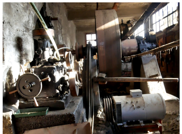
Figura 1.15- Centralina idroelettrica del mulino di Monterosso Grana
