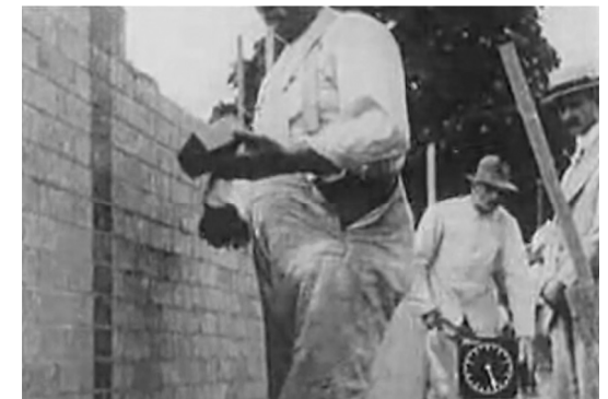
Figura 11: Il micro-cronometro Gilbreth viene incluso nel campo di ripresa insieme agli operai coinvolti nella posa di mattoni, in ordine di ottenere un riscontro spazio-temporale tra la pellicola e la realtà [36].
