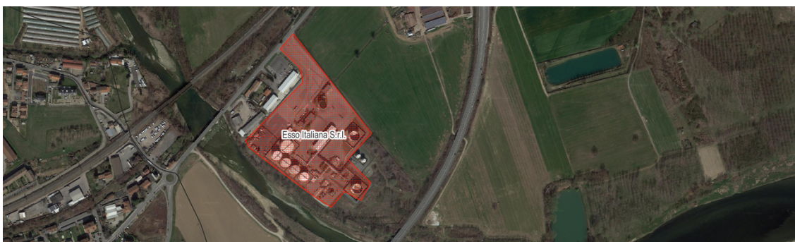
Fig. 49: Localizzazione stabilimento ESSO ITALIANA S.r.l (Fonte: elaborazione personale)
