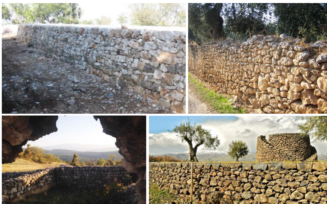
Fig.6 Esempi di costruzioni in pietre: muretti a secco
