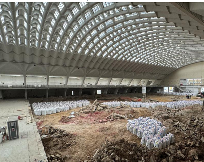
Lavoro in corso a Torino Esposizioni
