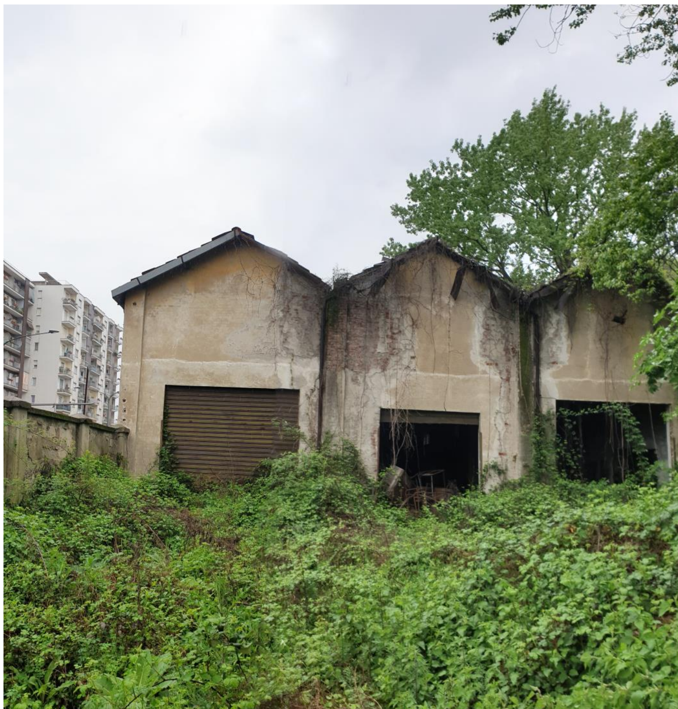
Fotografia 4, facciata sud dell'edificio deposito corto presente a ovest del lotto, lungo via S. M. Mazzarello.
