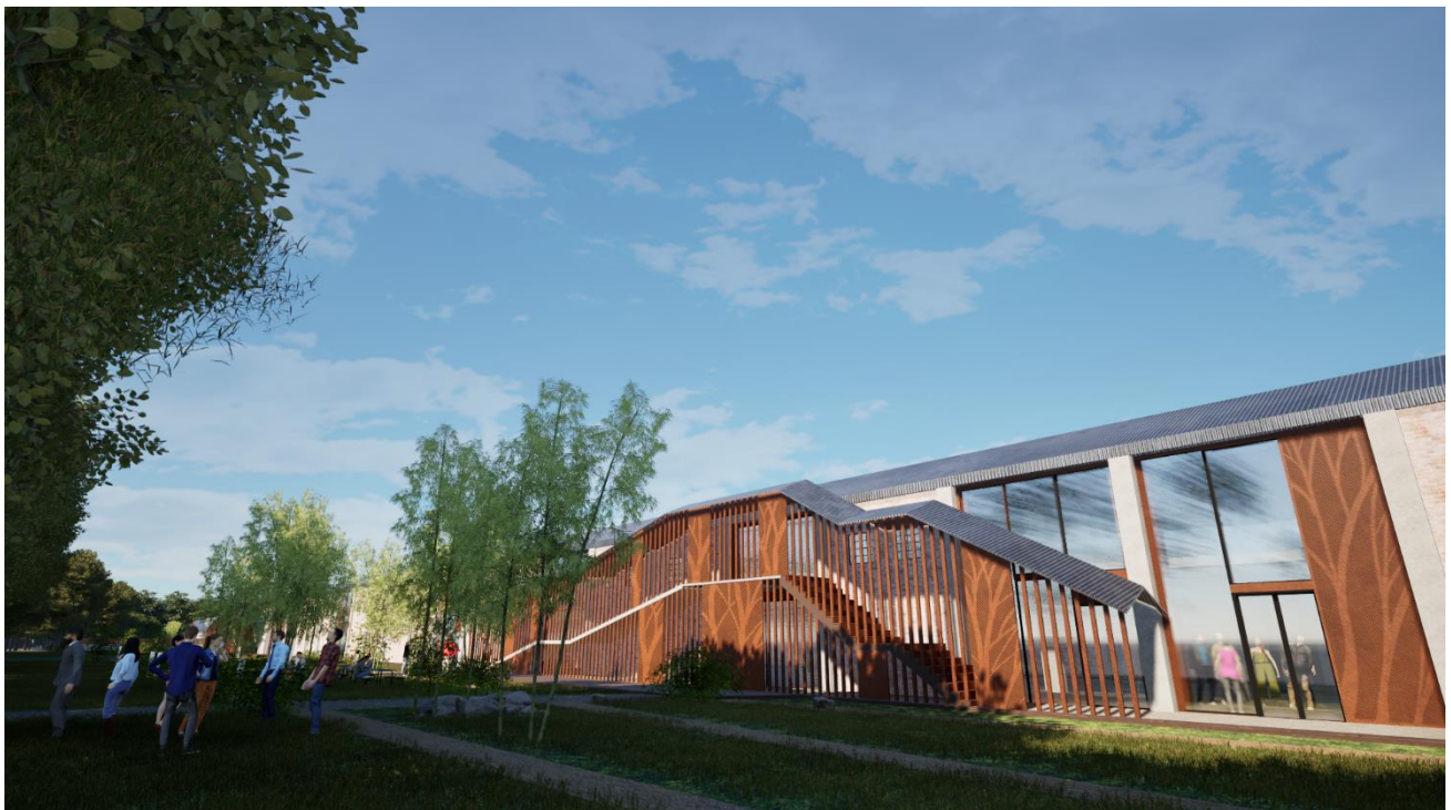
Fig. 13) Edificio deposito lungo, facciata est. Le rampe che conducono al piano primo, presentano delle sezioni rettangolari in corten con funzione di parapetto. Il cambio di piano avviene tramite scale o rampe, che garantiscono così l'accessibilità per tutti i bacini di utenza.
