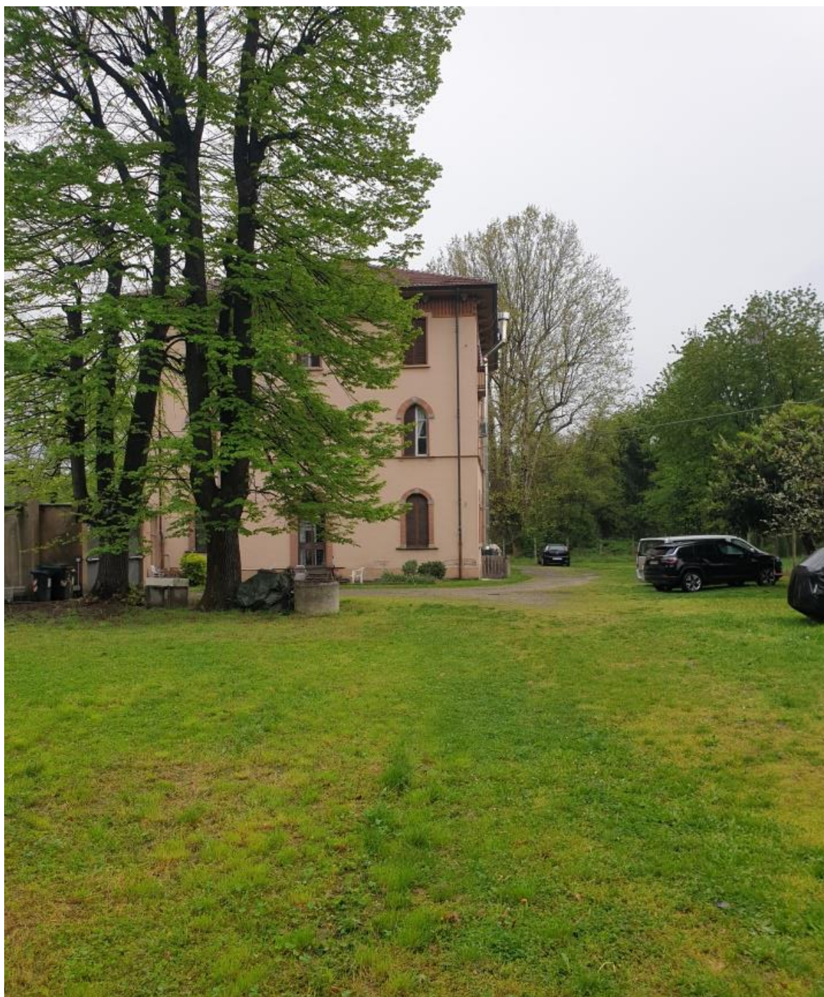
Fotografia 2, l'edificio escluso dagli interventi di riuso.
