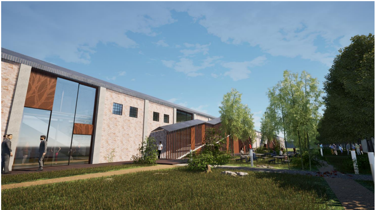
Fig. 12) Edificio deposito lungo, facciata est. Le lastre in corten microforato sono presenti anche nei due edifici deposito, posti a parziale schermatura dei serramenti a tutta altezza collocati a sostituzione delle preesistenti partizioni in muratura.
