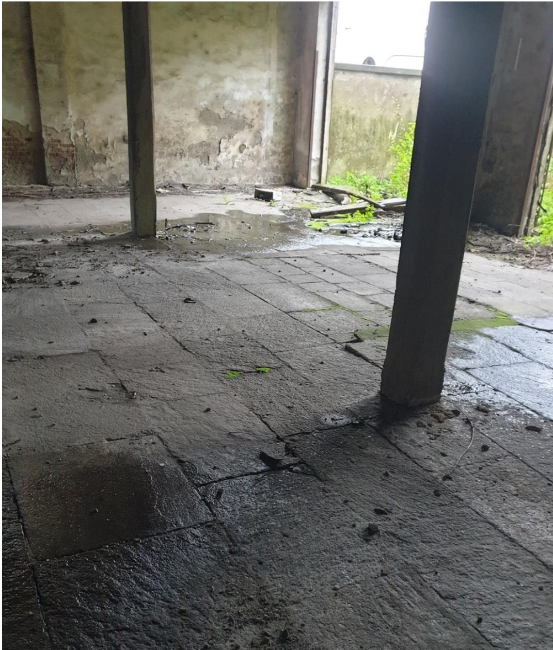
Fotografia 9, Pavimentazione in pietra di Luserna presente all'interno dell'edificio deposito corto. Si considera uno spessore delle stesse di circa 4 cm.
