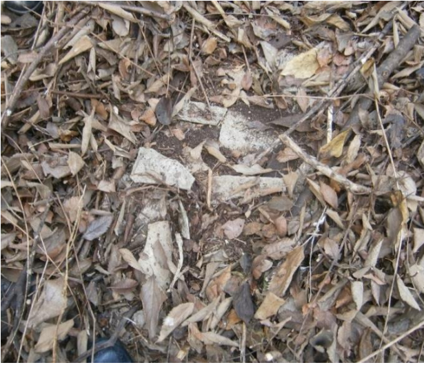
Fig.3) Resti di copertura in fibra d'amianto - fotografia Esercito Italiano
