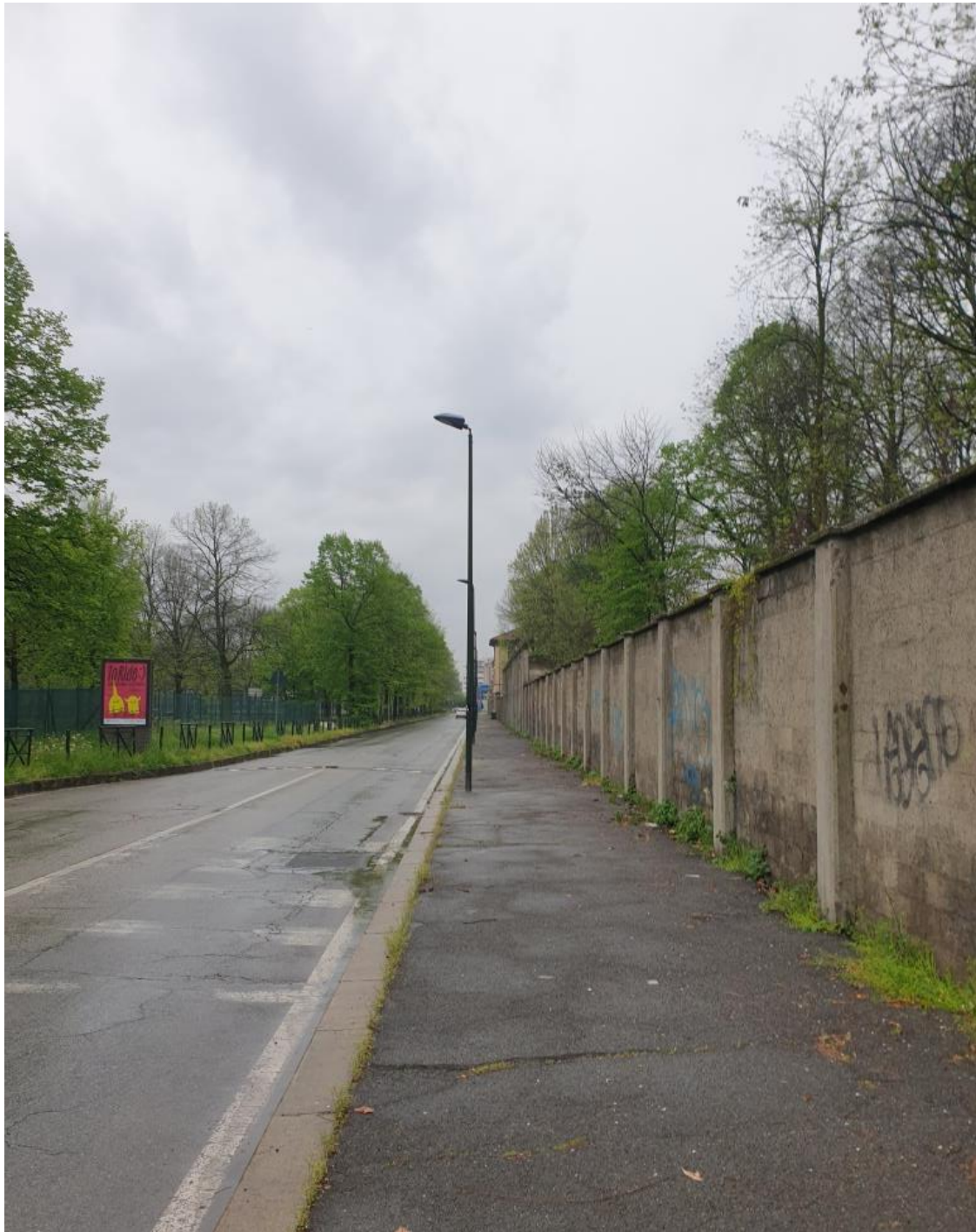
Fotografia 1, il perimetro lungo c.so Brunelleschi. A sinistra il parco Ruffini, a destra il muro perimetrale in blocchi di cls dell'edificio tettoia. L'altezza del perimetro è di circa 2,80 m.
