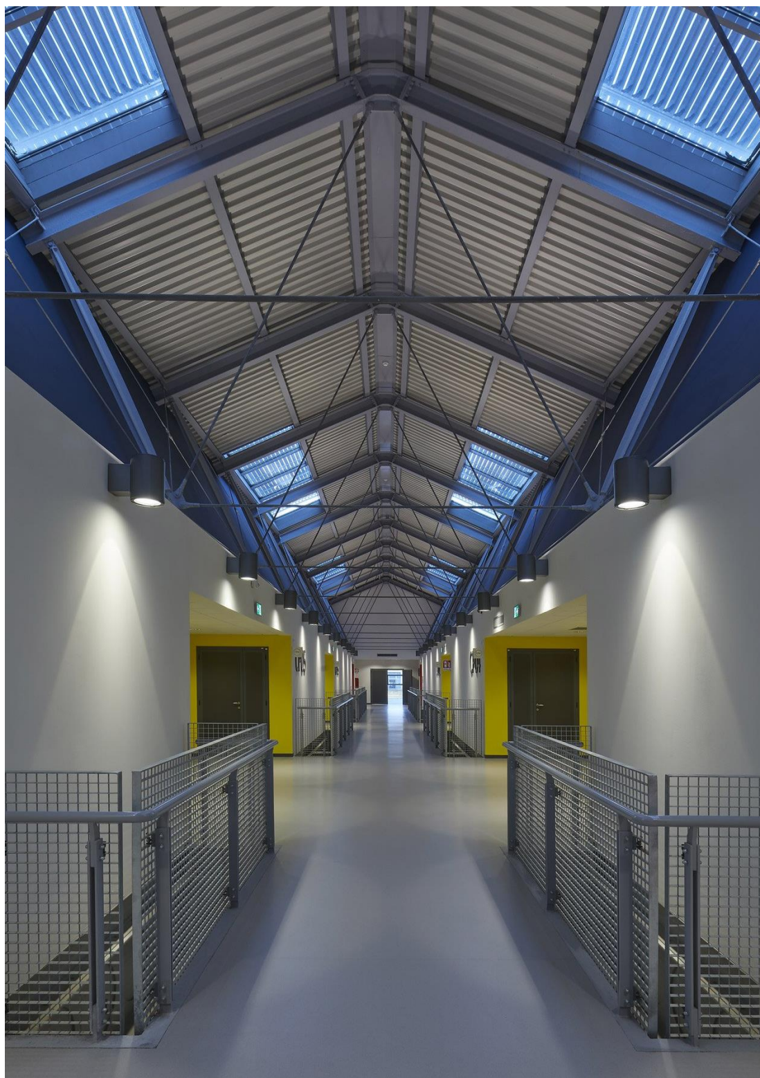
Fig 3) Riferimento progettuale, fotografia interna. Ex Caserma Perrone, Novara ,progetto Lamberto Rossi Associati. Fotografia dal sito: "The Plan"
