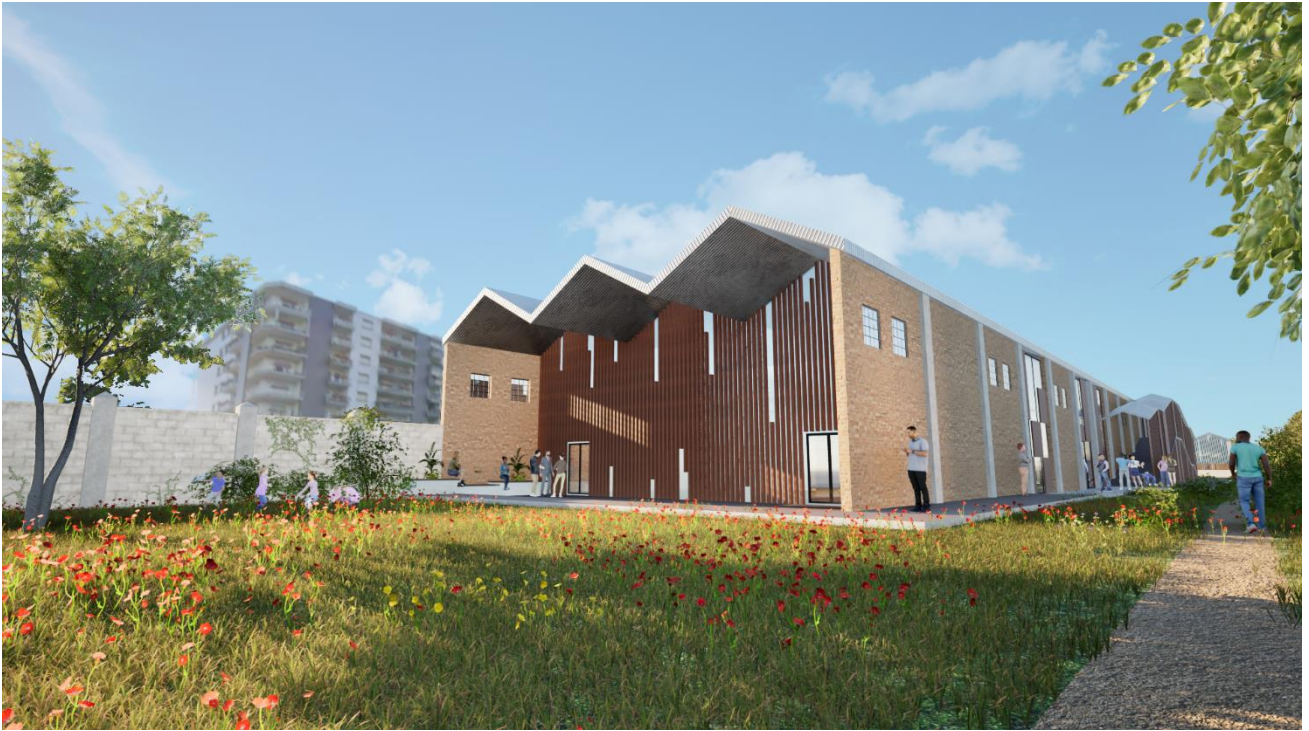
Fig. 14) Edificio deposito corto, angolo sud-est.
