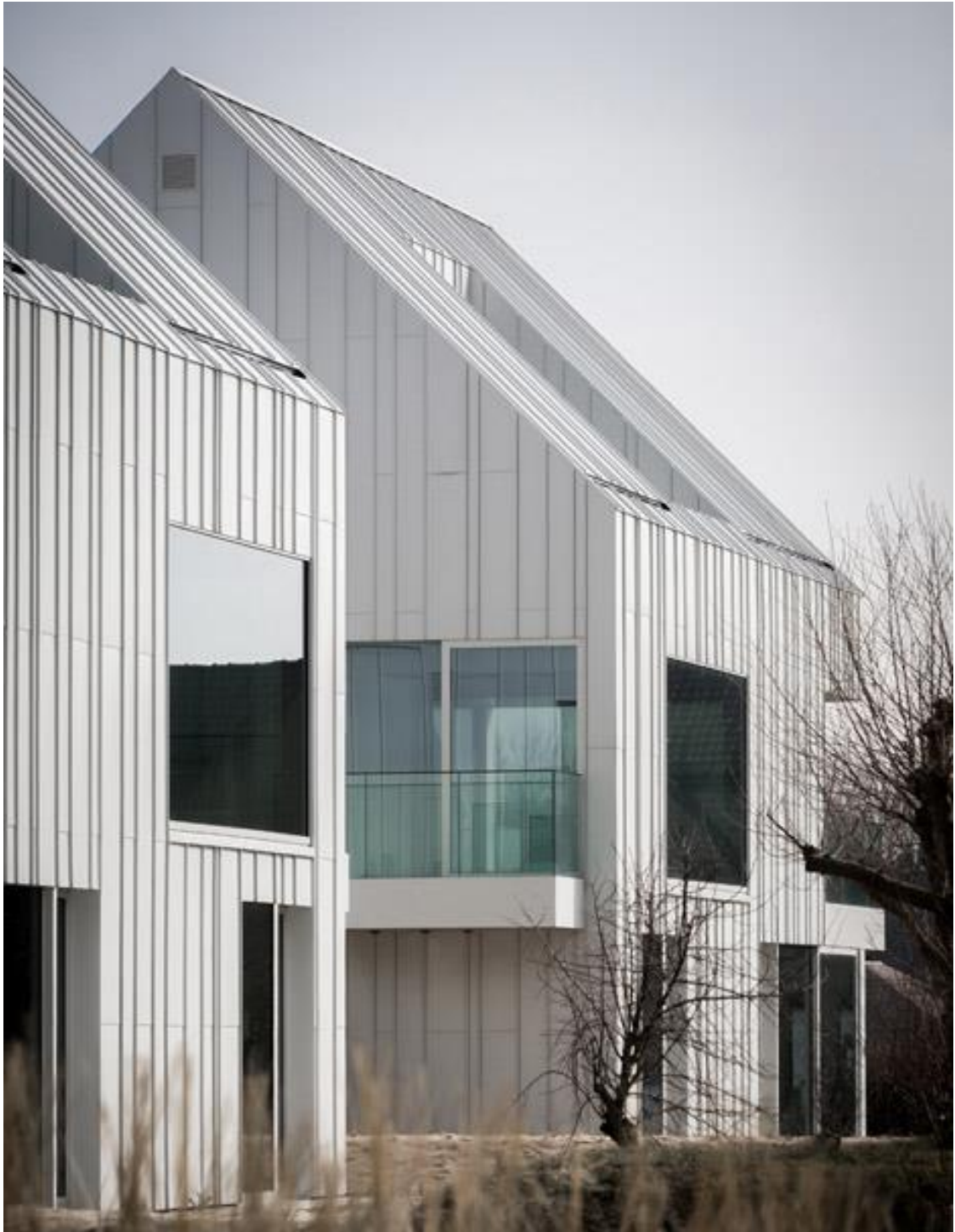
Fig 2) Riferimento rivestimento esterno, Blanco Oostduinkerke Residence, Belgio, progetto BURO II & ARCHI+I,
