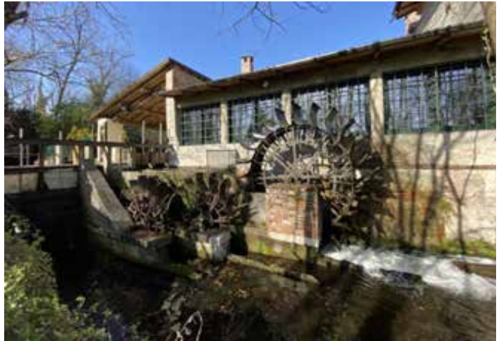
Mulino del Pericolo, ruota con impianto mini-idroelettrico
