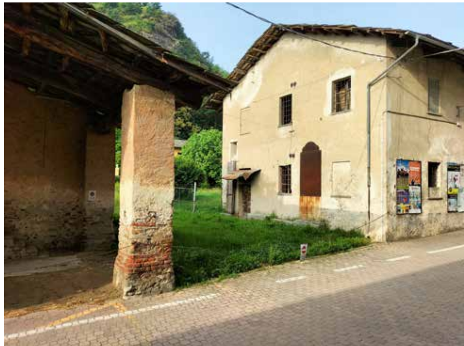
Fig.12. Foto del Mulino dei Benso, prospetto est (22/12/2024).
