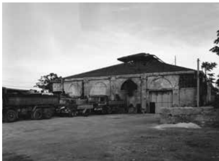
Edificio del Deposito Locomotive prima dell'intervento di recupero
