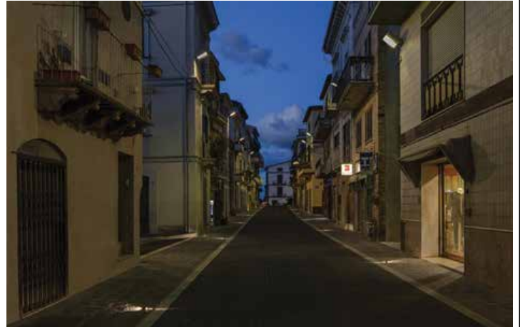
Via centrale di Paglieta illuminata da apparecchi ad incasso nel pavimento e proiettori
