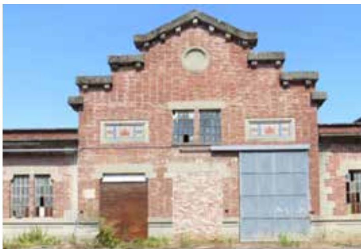
N.O.V.A., esterno in stato di abbandono
