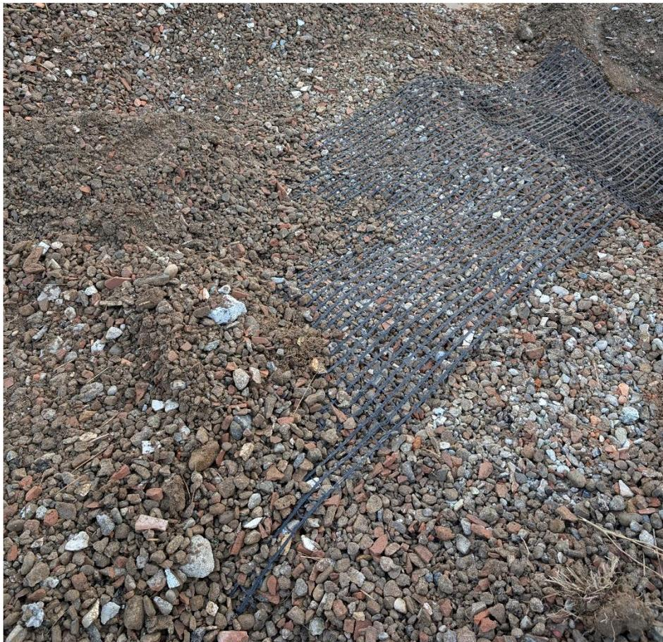
*Figura 6.17: Stesura e ricoprimento della geogriglia nel rilevato B*
