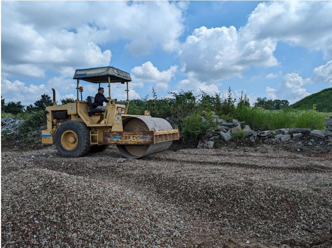
*Figura 6.14: Compattazione mediante rullo vibrante*
