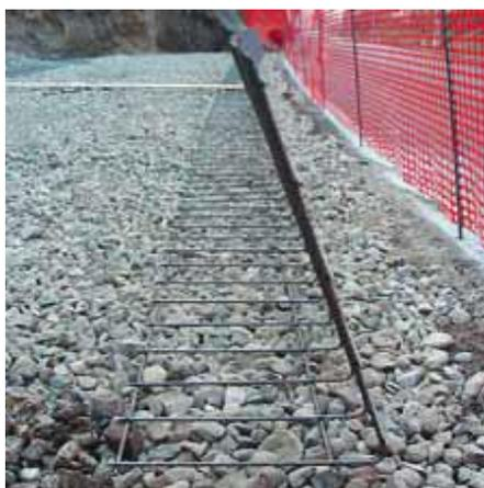
*Figura 3.3: Preparazione del piano di posa*
