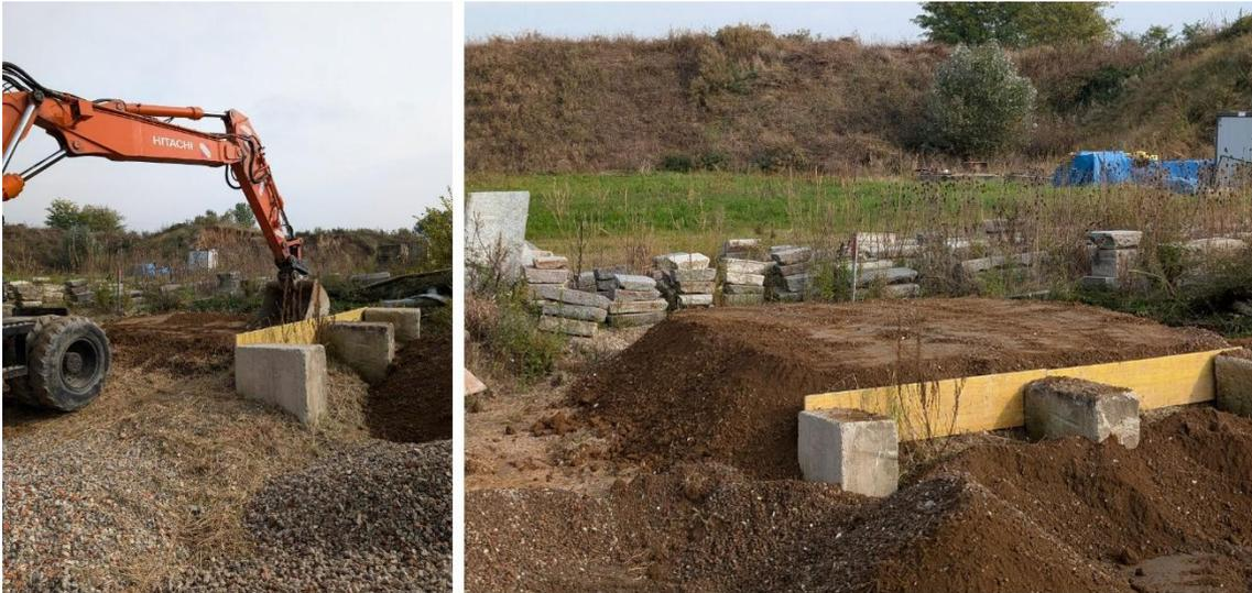
*Figura 6.16: A sinistra ultimazione del rilevato A. A destra immagine del rilevato A concluso.*
