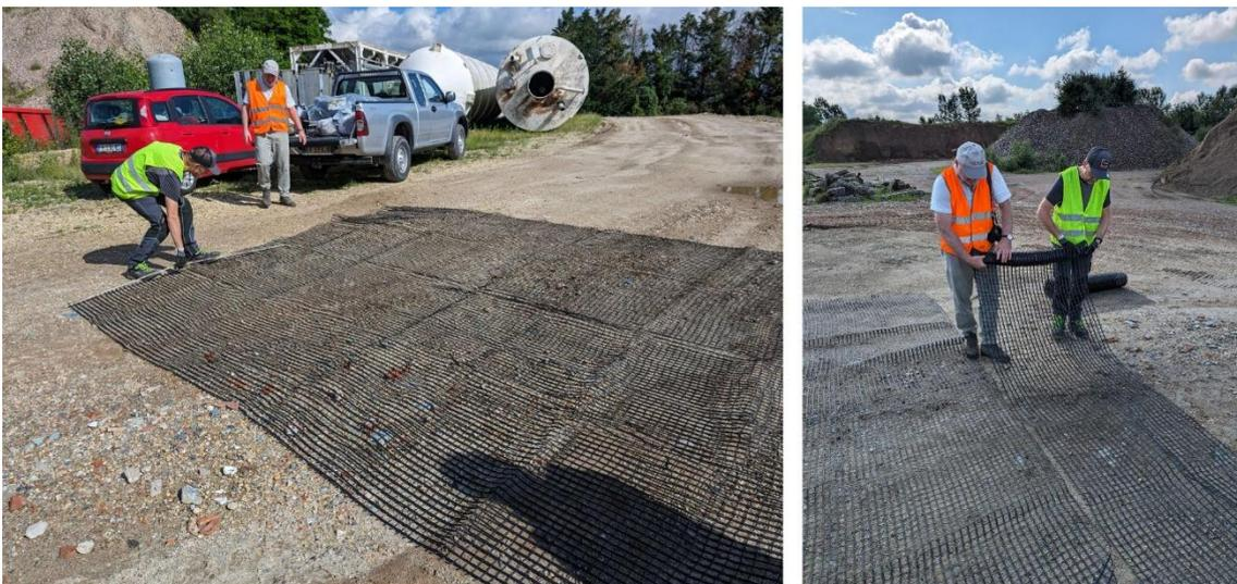
*Figura 6.15: Preparazione geogriglie in strisce 1x4 metri*
