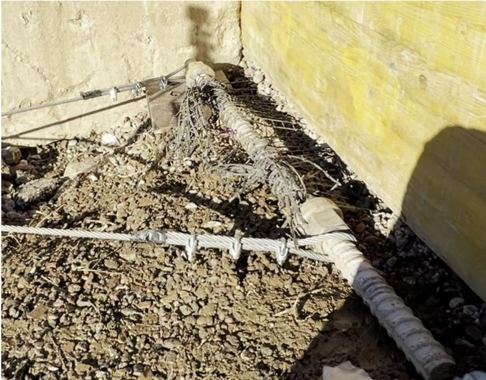
*Figura 6.23: Collegamento alla barra di acciaio tramite legatura dei filamenti longitudinali*
