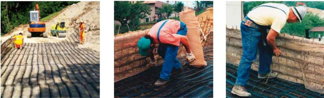
*Figura 3.4: Montaggio del sistema*
