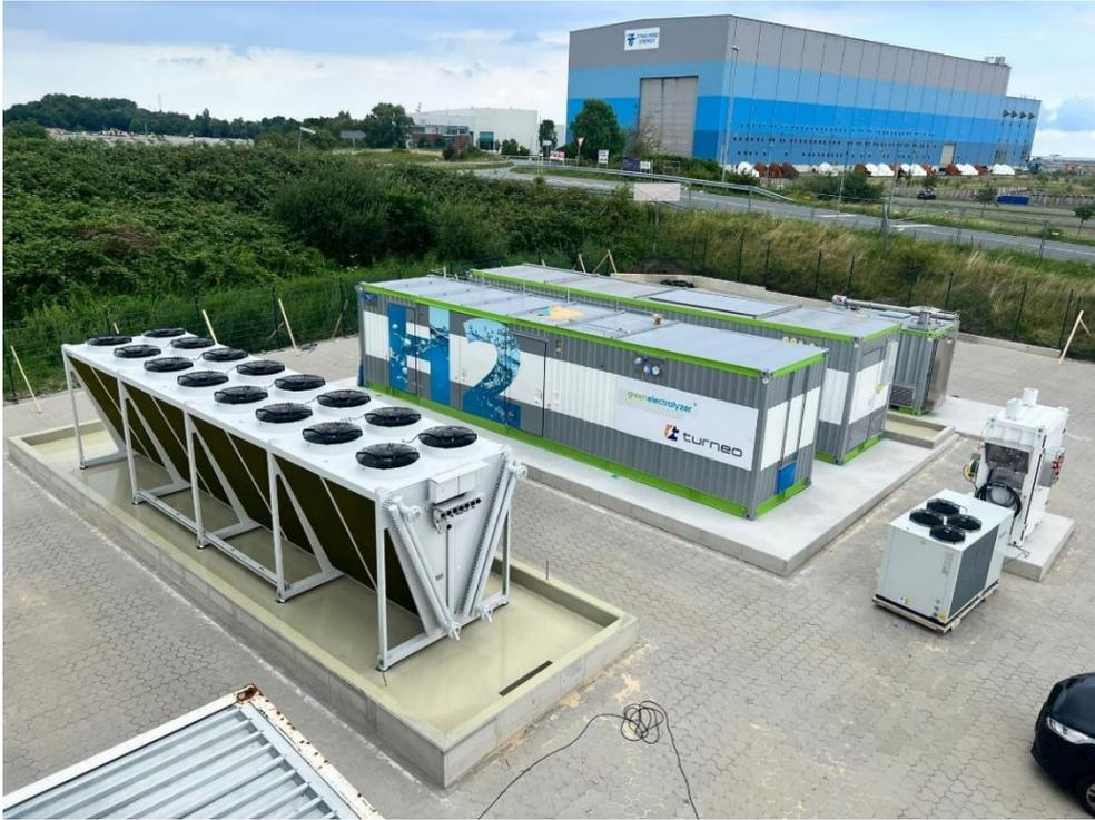
Figura 4.4: Un elettrolizzatore PEM da 5 MW di potenza nominale (Hyfindr GmbH)
