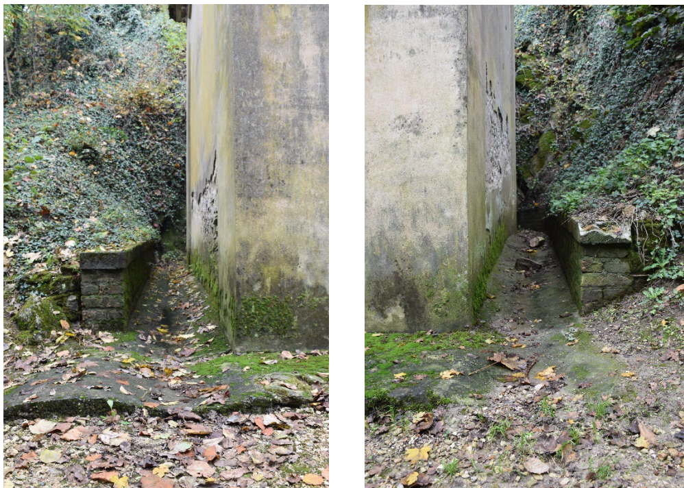
Figura 48: Scolo acque meteoriche sinistro e destro.
