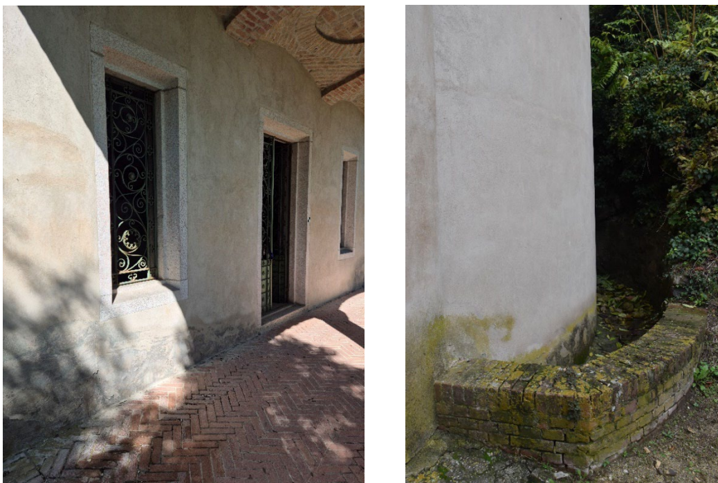
Figura 58: Interno pronao (sinistra) e muro di contenimento delle acque meteoriche destro (destra).
