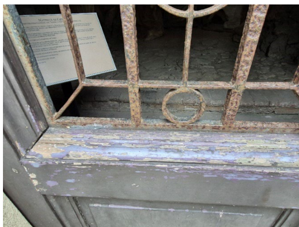
Figura 55: Alterazione cromatica del pigmento della porta.
