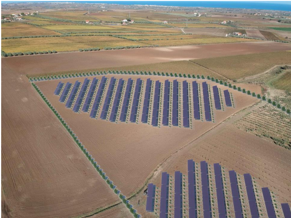
Figura 29 - Foto simulazione, punto di ripresa 1, foto drone (elaborato fornito da Studio Eko' srl [51])
