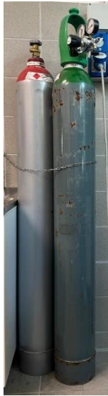
Figura 19: Bombola contenente gas inerte.
