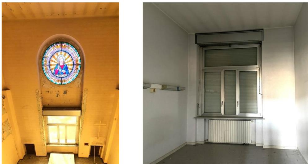
Figura 30: Immagini dello stato di fatto degli ambienti interni in cui si può notare la direzione dei travetti in calcestruzzo che compongono i solai in laterocemento. Immagine fornita.
