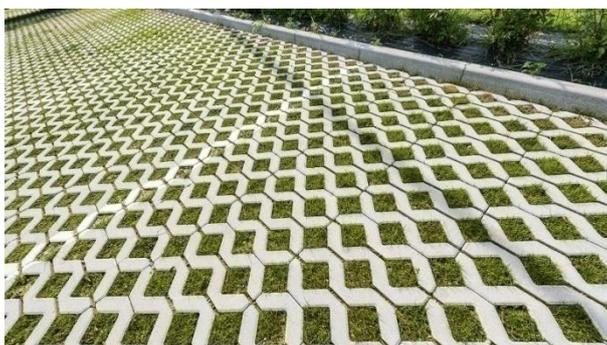
Figura 16: Tipologia di grigliato erboso inserito nel progetto<sup>23</sup>.
