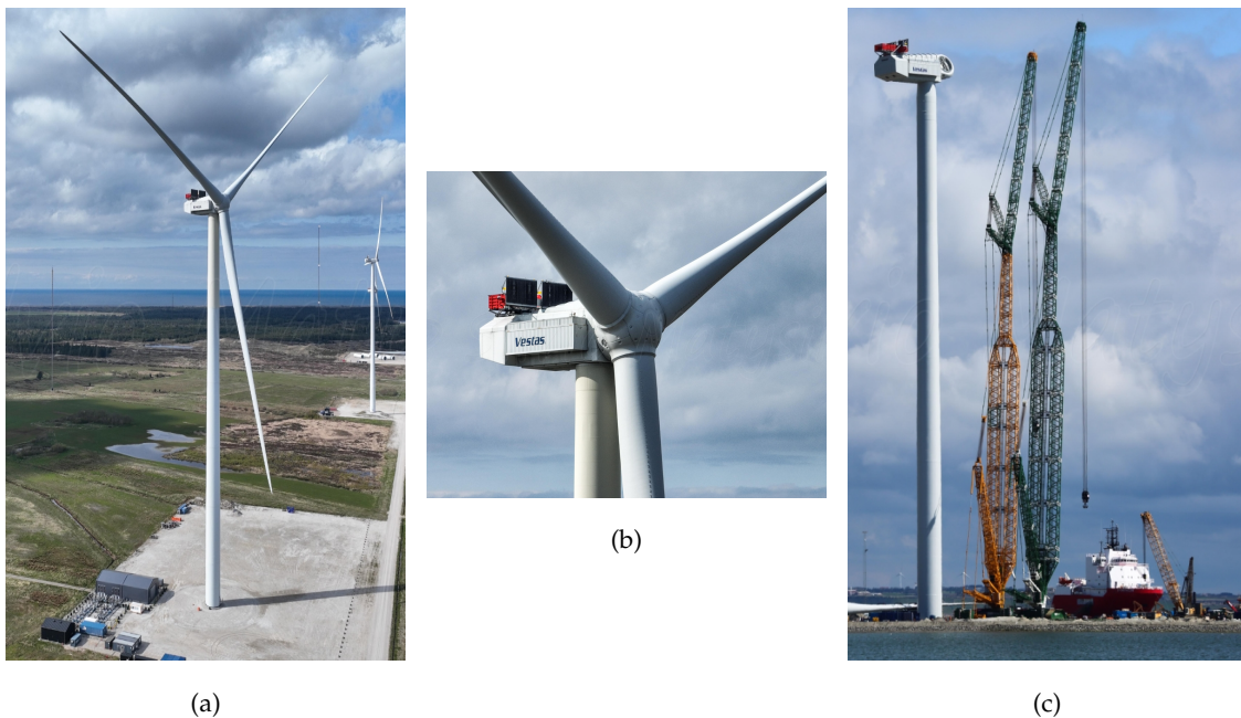
Figure 2.4: Vestas V236-15, la turbina eolica on-shore tra le più grandi esistenti (fonte: Vestas )
