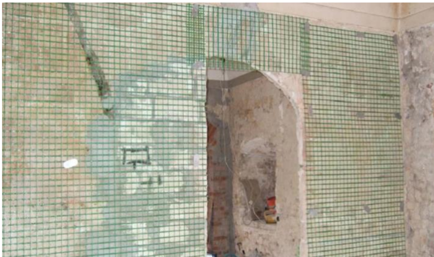
Figura 5 - Interventi migliorativi con FRP
