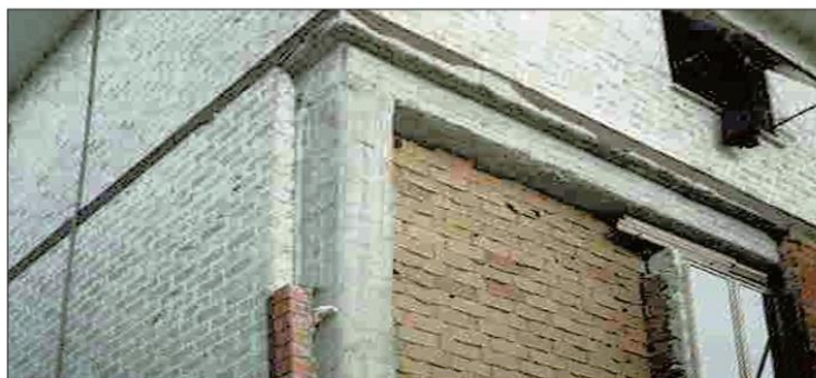
Figura 36 Esempio di dissimmetrie delle tamponature [14]
