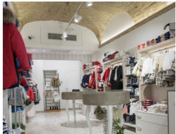
Figura 62 Volta a botte con lunette in un'attività commerciale del centro storico
