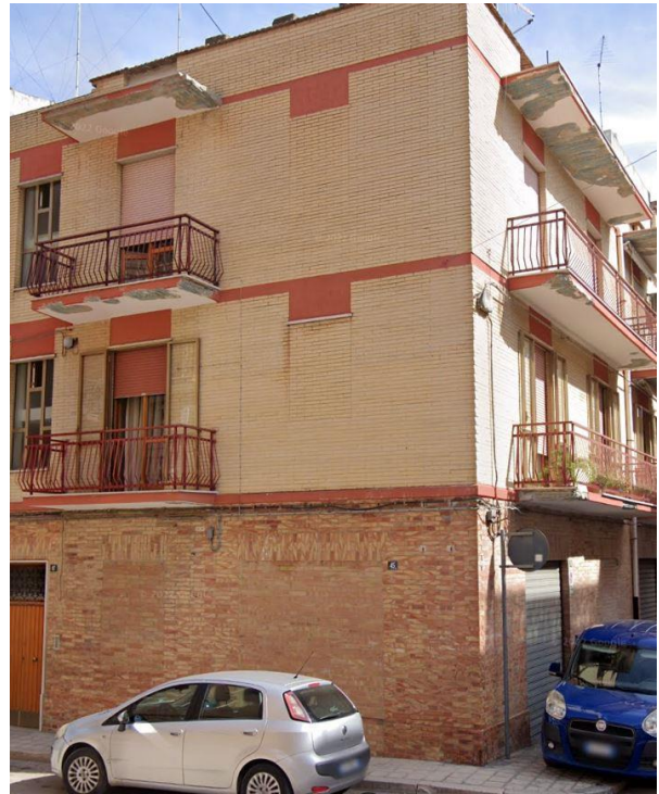
Figura 75 Discontinuità data dalla chiusura di alcune finestre e aperture al piano terra nella tipologia MUR1 comparto C02
