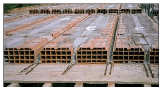
Solai in laterocemento gettato in opera.
