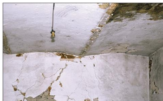
Solaio con travi di ferro a voltine.
