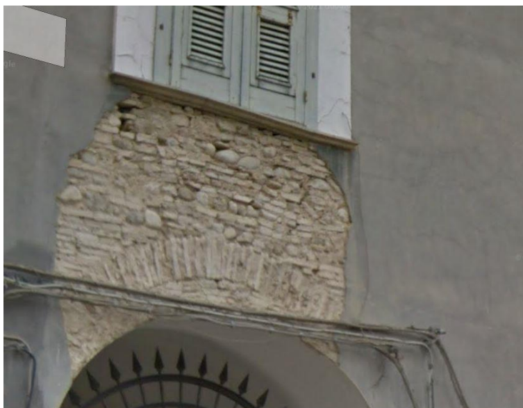
Figura 66 Tessitura muratura tipologia MUR2
