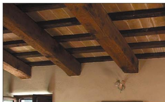
Solaio in legno con mezzana
