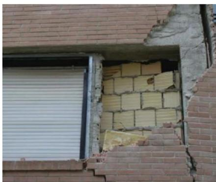
Figura 11: Scenario post-sisma: distacco ed espulsione fuori-piano del paramento interno su tamponamento in muratura.
