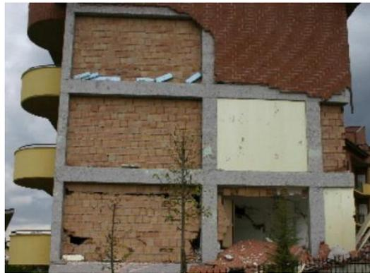
*Figura 13: Fessurazione nel piano ed espulsione fuori piano di tamponamenti in muratura: a) L'Aquila, 2009 [22].*
