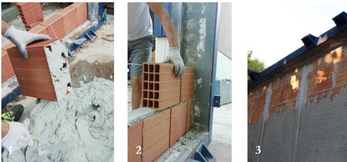
*Figura 26: Sequenza costruttiva del tamponamento: 1) posa della malta sulla testa del blocco, 2) posa del blocco sul letto di malta, 3) intonacatura [10].*
