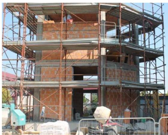
Figura 2: Struttura con telaio in c.a. e tamponamenti laterizio in costruzione [9].
