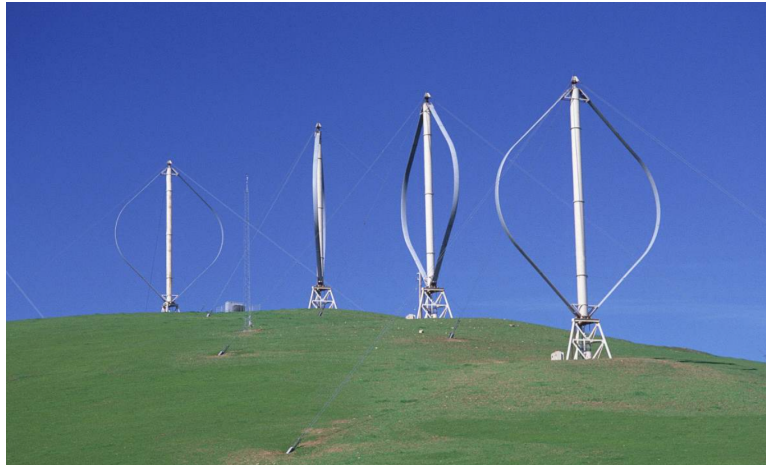
Figura 1.3: Turbine ad asse verticale - VAWT
