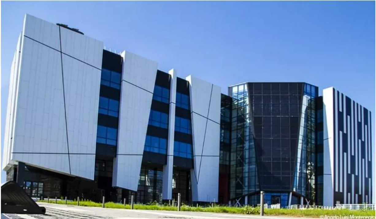
Figura 12 - Energy Center Torino
