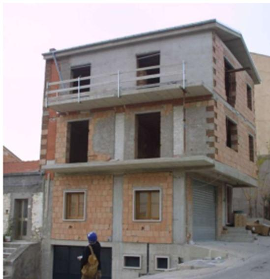
Fig. 7 - Edificio con presenza di sbalzi
