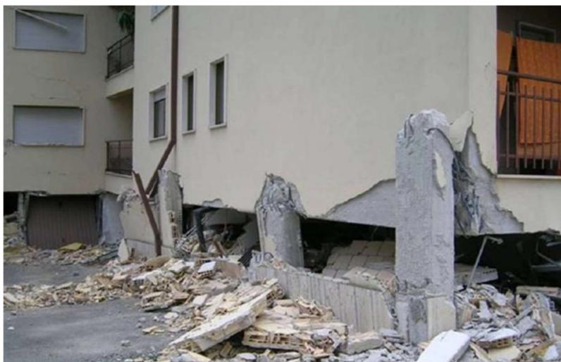
*Fig. 9 - Meccanismo di piano sofficе nel terremoto dell'Aquila 2009*
