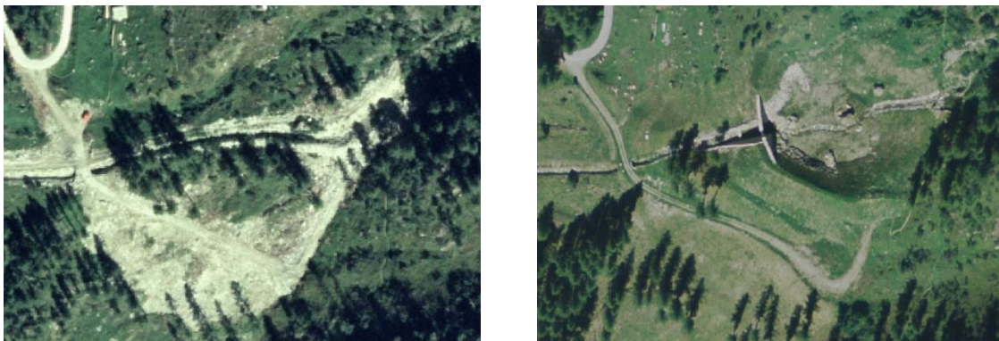
Figure 8 : Construction of a « dépotoir », 2003 vs 2007
