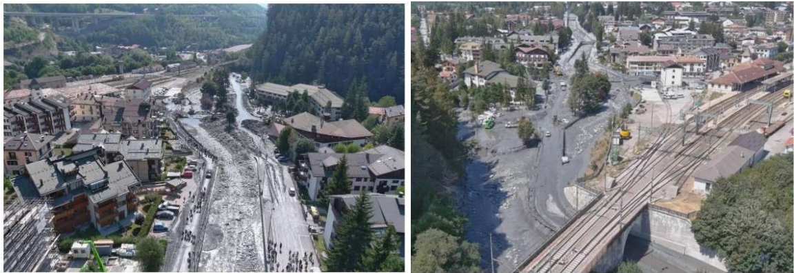
Figura 3.16: Vista dell'area interessata dall'accumulo di materiale, il ponte della stazione e il Commissariato di Polizia. A destra da monte, mentre a sinistra da valle
