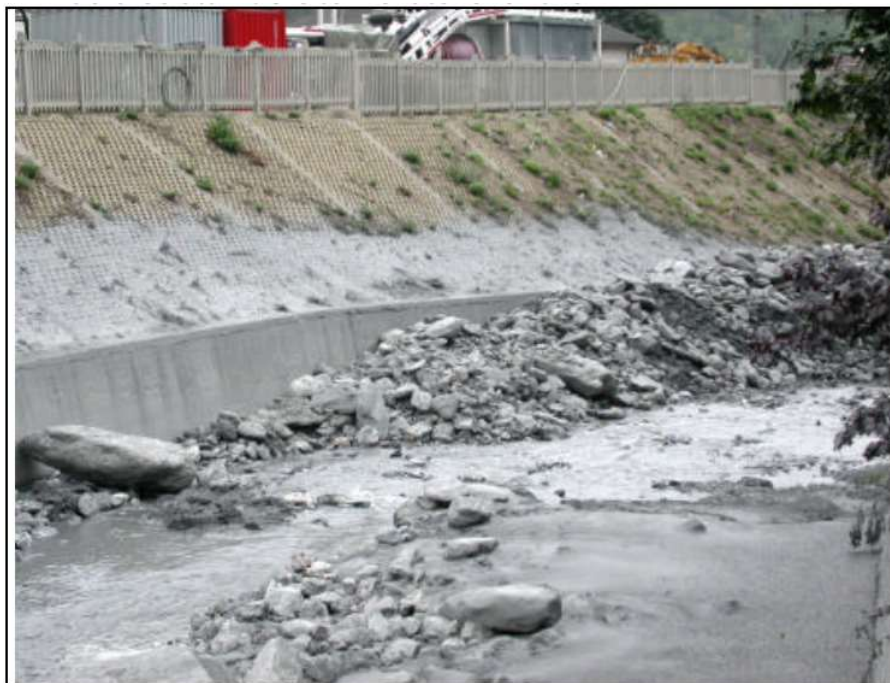
Figura 3.10: Torrente Frejus immediatamente a monte della confluenza nella Dora di Valle stretta. Caratteristiche del deposito (in parte mobilizzato antropicamente) e del livello massimo della colata visibile sul rilevato ferroviario.
