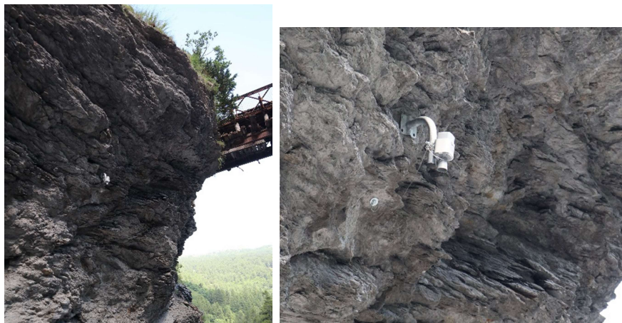
Figura 5.16: Sensore di livello WLM2 installato in corrispondenza del ponte01
