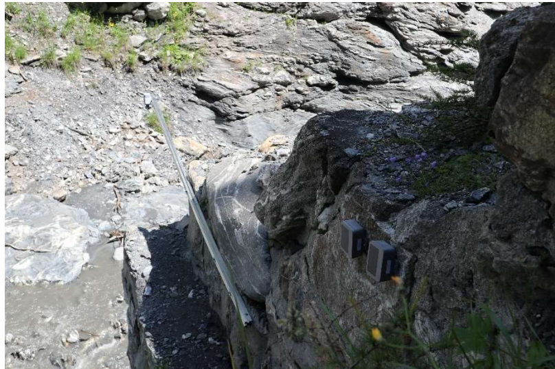
Figura 5.15: Sensore di livello WLM1, accelerometro ACM4 e sismometro EQ4 installati sulla soglia03
