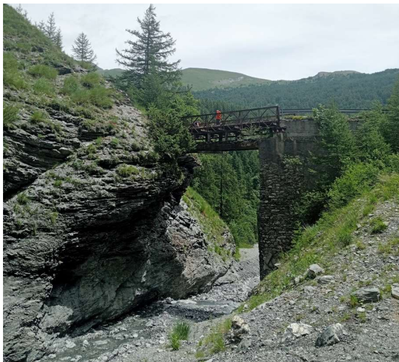
Figura 3.25: Ponte di ferro, posizionato poco a valle della barriera 5
