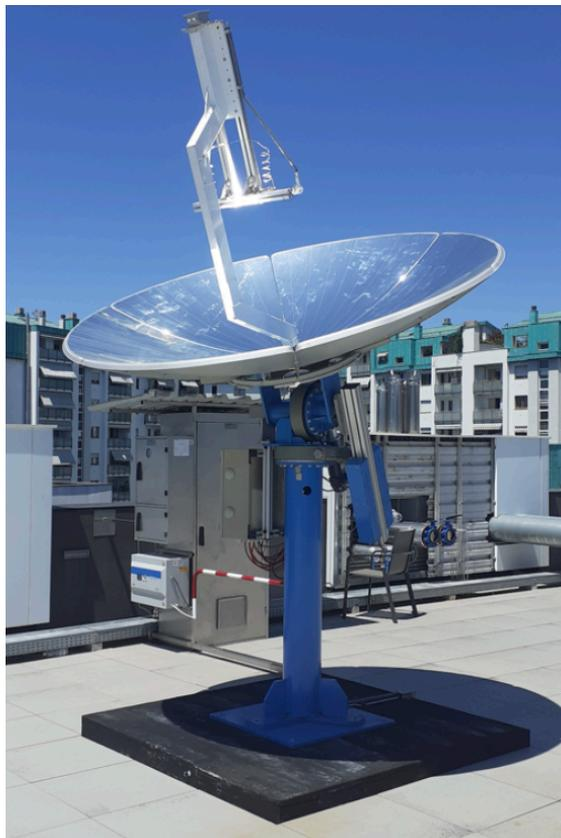
Figura 62 - Concentratore solare installato sul tetto dell'Energy Center
