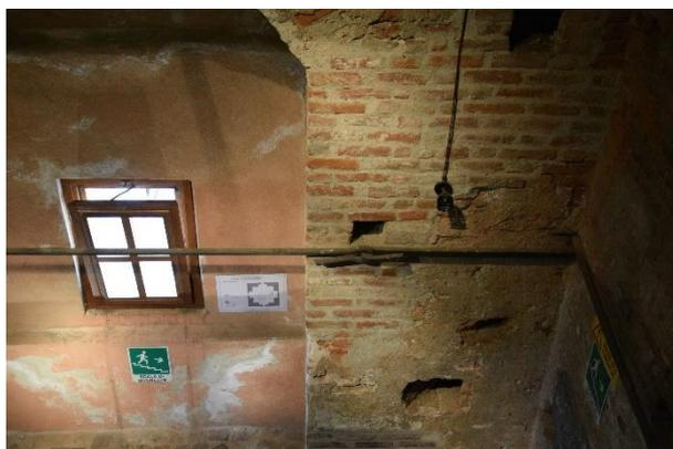
*Fig. 10* – Particolare delle catene metalliche a consolidamento della muratura esistente (Alessandro Corrao©).
