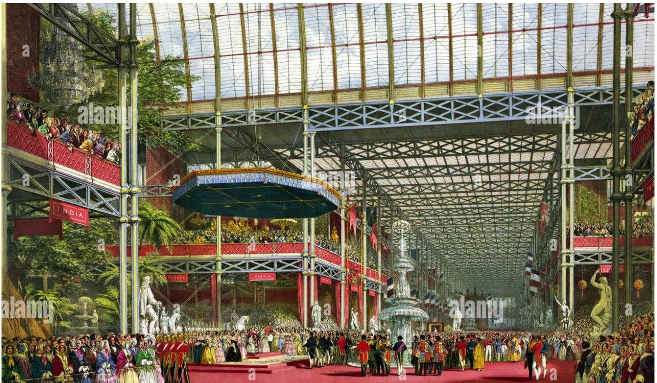
Questa struttura geometrica ebbe un utilizzo innovativo sotto diversi punti di vista. L'uso di sostegni di ferro permetteva una totale rinuncia a grossi pilastri e muri portanti tipici delle architetture tradizionali, permettendo la totale costruzione della superficie esterna in vetro. Inoltre, la produzione di elementi costruttivi prefabbricati in serie avrebbe facilitato enormemente i lavori, compreso l'eventuale spostamento e ricollocazione dell'edificio.
