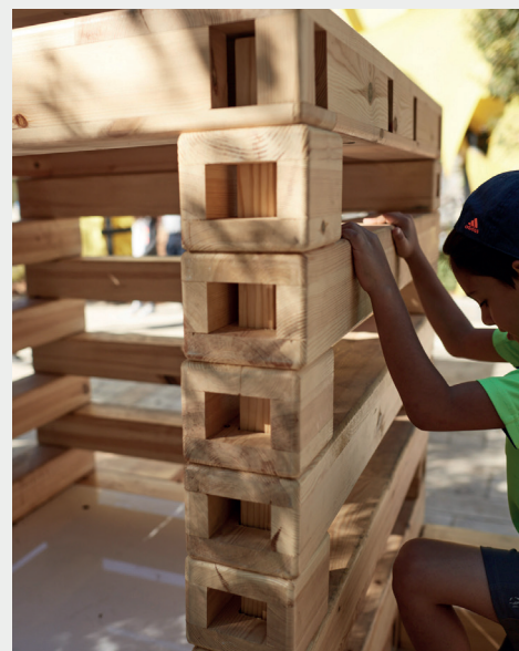
Fig. 74: Dettaglio dell'assemblaggio dei pezzi che compongono il parchi giochi pop-up Stackable Playscapes con il solo uso della forza di gravità (Deezen, 2018a).
