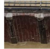
**0.2 Pulitura meccanica e fisica e risarcitura lesioni malta:** Si effettua un riempimento con materiale organico così da ristabilire la continuità muraria. La procedura di pulitura meccanica della superficie prevede, anche in questo caso, l'utilizzo di spazzole (setole di nylon) per la rimozione delle efflorescenze con il Cocoon, supportante a base fossile e di impacchi a base di solvente per la rimozione di macchie superficiali.
