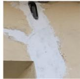
**0.3 Rimozione e risarcitura:** In seguito alle analisi, risultasse la riparazione aggiunta, non compatibile per composizione dei materiali, si opterebbe per la rimozione di essa e la risarcitura prima con rinzaffo di malta a base di calce e un secondo strato con intoco a base calce. Infine stesura di un fissativo.
