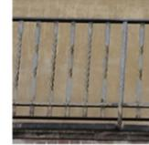
**0.10 Restauro balaustre in ferro:** Le balaustre in ferro del balcone e del ballatoio presentano ruggine in alcuni punti a causa della mancanza del film protettivo antiruggine e di vernice.
