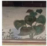
**0.11 Restauro pitture murarie:** consolidamento superficiale dello strato pittorico e reintegro del supporto decorato alla muratura tramite micro-iniezioni. Successivamente, si procederà al ripristino volumetrico delle sezioni di intonaco mancanti utilizzando malta a base di calce e alla ricostruzione delle decorazioni mancanti.
