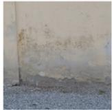
**0.5 Pulizia e risarcitura lesioni:** Dopo aver effettuato una pulizia meccanica della superficie interessata, si effettua una rimozione dell'intonaco decoeso e si procede con la risarcitura, seguendo le indicazioni del punto 0.3 e successivamente del punto 0.4.
