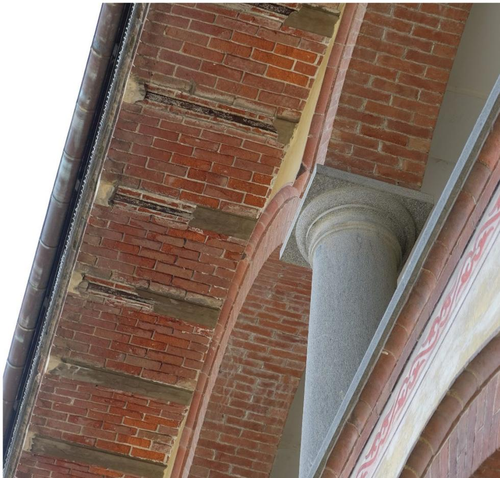
F.141. Ballatoio del piano secondo, dettaglio dei travetti in ferro utilizzati a sostegno del solaio e delle voltine di quarto (immagine sopralluogo 12/10/2023)
