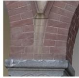
**0.1 Pulitura meccanica e fisica:** La procedura di pulitura meccanica della superficie degli archi prevede l'utilizzo di spazzole (setole di nylon) per la rimozione delle efflorescenze con il Cocoon, supportante a base fossile e di impacchi a base di solvente per la rimozione di macchie superficiali.
