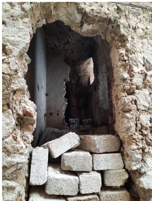
Fig. 195 - Breccia nel muro perimetrale, per accedere al passaggio coperto
