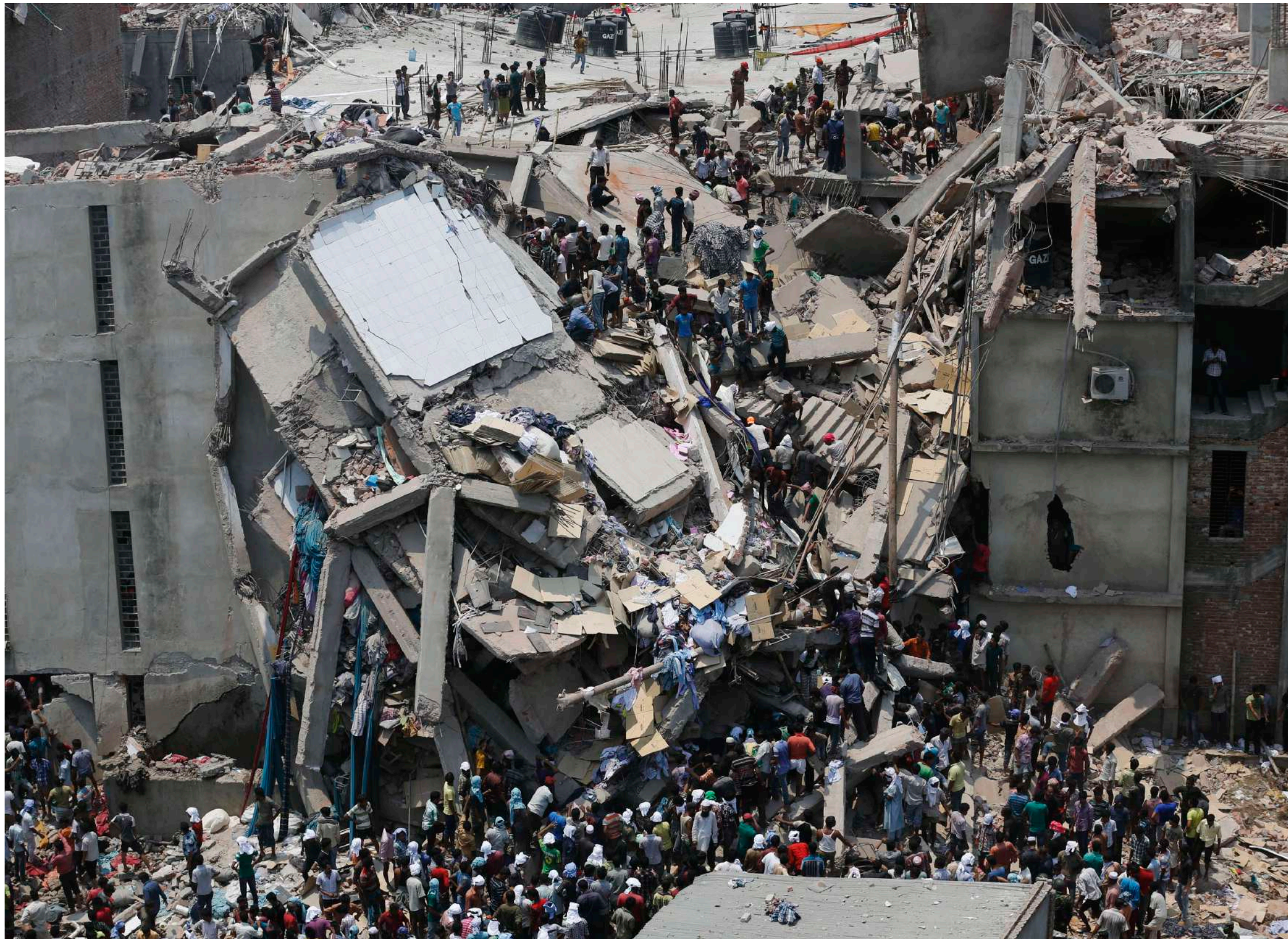
fig 10 Rana Plaza dopo il crollo.
