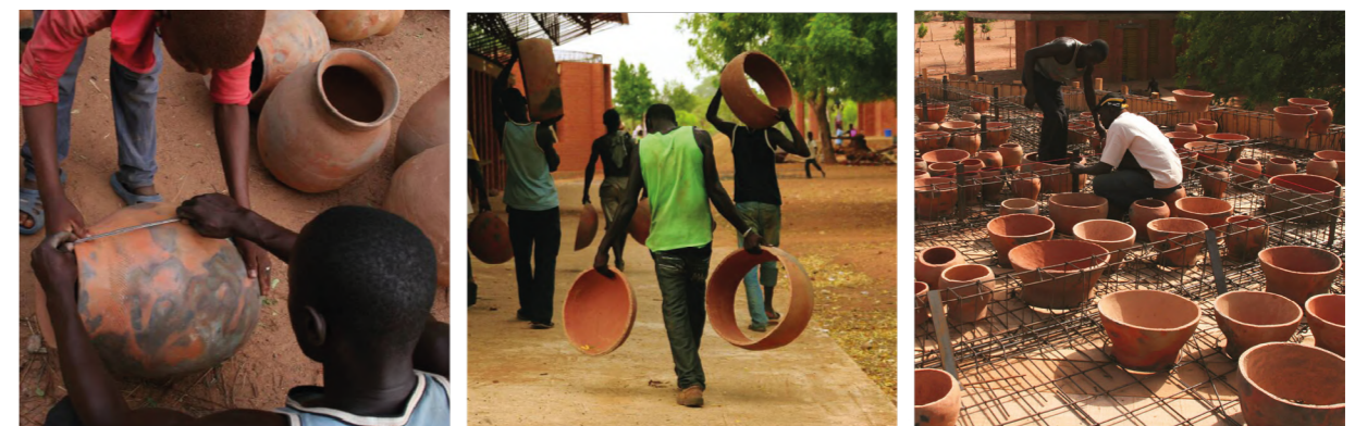
Figura 48: Processo di costruzione e integrazione dei vasi in copertura. Fonte immagine: https://www.domusweb.it/it/architettura/2012/10/29/utopia-di-terra.html (ult. cons. 05/06/2024)
