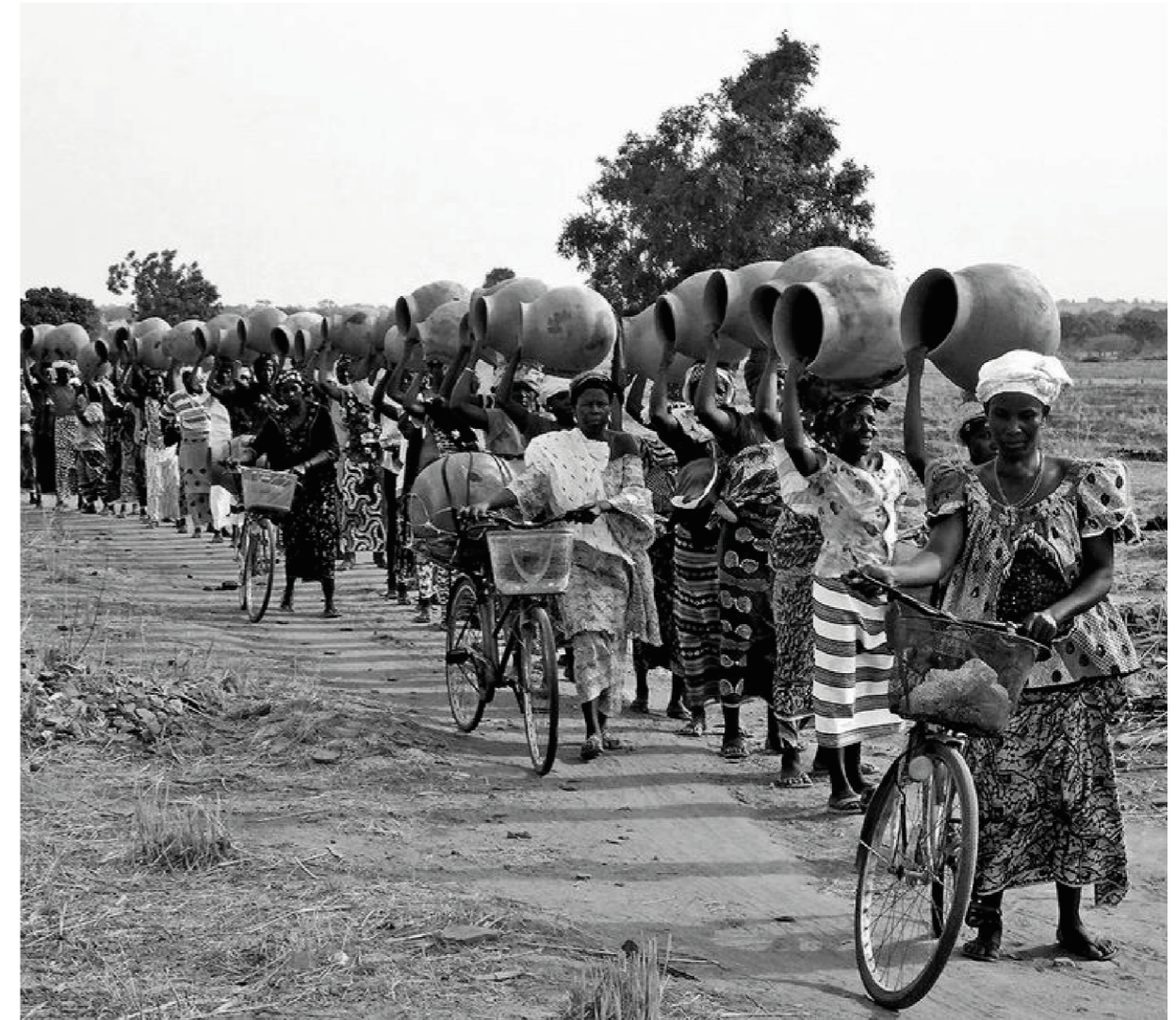
Figura 38: Nella figura si osservano le donne del villaggio di Gando intente a trasportare i vasi in terra cotta, di loro produzione, al sito di progetto. I vasi sono stati integrati nel massetto di chiusura del sistema di copertura della biblioteca della scuola primaria di Gando, realizzata da Kéré. Questo è un esempio di progettazione off-site adattabile al contesto di tesi, che non esclude la costruzione partecipativa della comunità femminile , ma la valorizza, pure in virtù della parità di genere. Immagine ripresa da https://arquitecturaviva.com/works/biblioteca-de-gando-10 (ult. cons. 12/06/2024)
