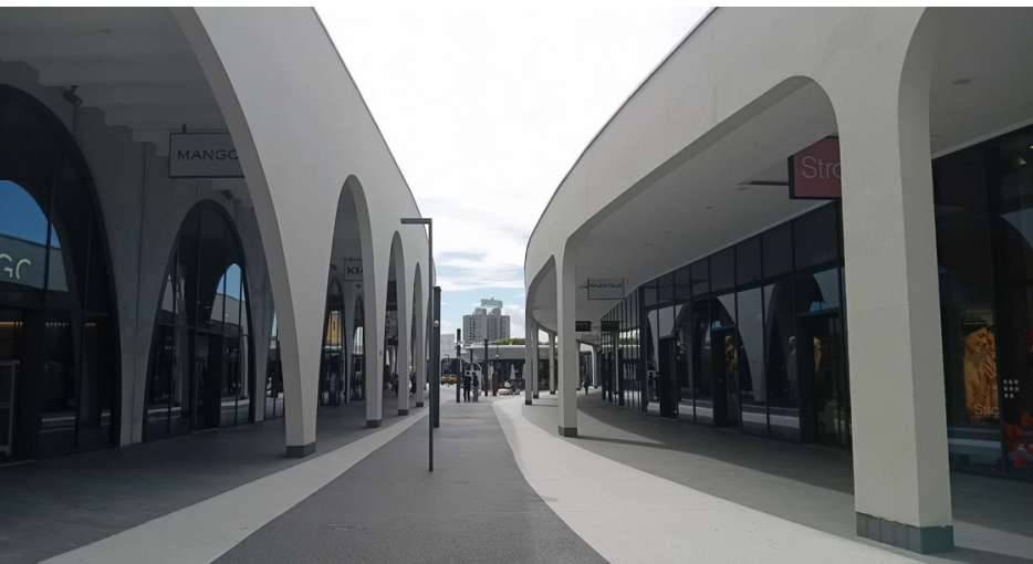
Figura 7. S. Cipriano, Centro Commerciale To Dream, struttura ad archi ripetuti, Torino, 2024.
