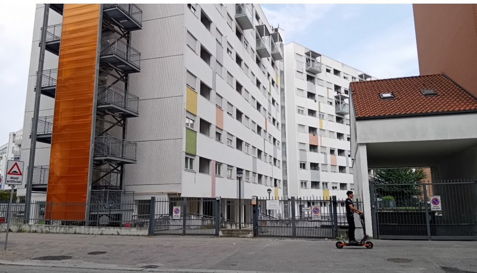
Figura 13. S. Cipriano, Albergo sociale Sharing, vista ingresso laterale, Torino, 2024.
