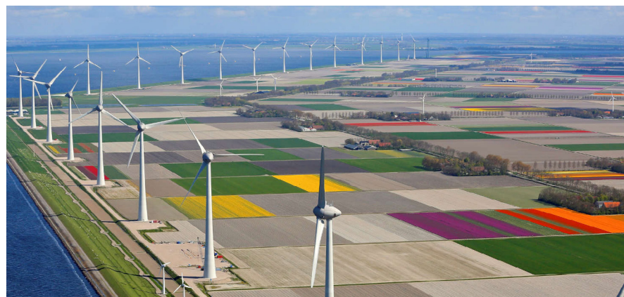
Fig 95 - Zuidwester onshore wind farm, Noordoostpolder. Source - RWE AG.
