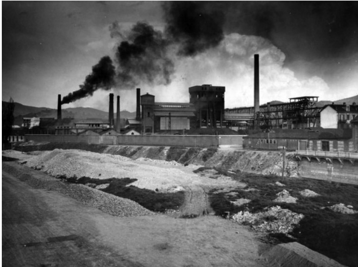
Cantiere per deviare l'alveo della Dora, 1930, Archivio Storico Fiat
